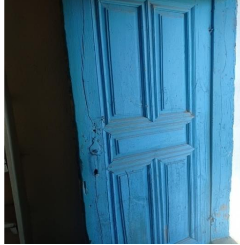
Resim 3.126. Odanın Giriş Kapısı
