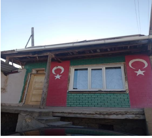
Resim 3.97. Odanın Batı Cephesi
