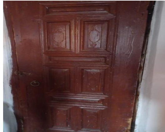
Resim 3.76. Odanın Giriş Kapısı
