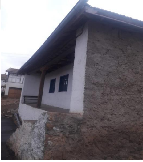
Resim 3.64. Odanın Kuzeydoğu Cephesi
