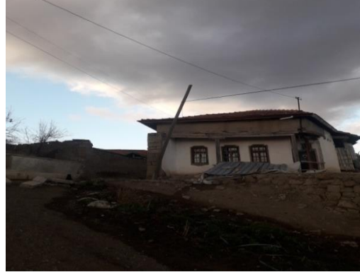
Resim 3.35. Odadaki Güney Cephesi
