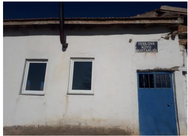
Resim 3.91. Odanın Batı Cephesi
