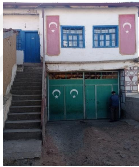
Resim 3.133. Odanın Batı Cephesi
