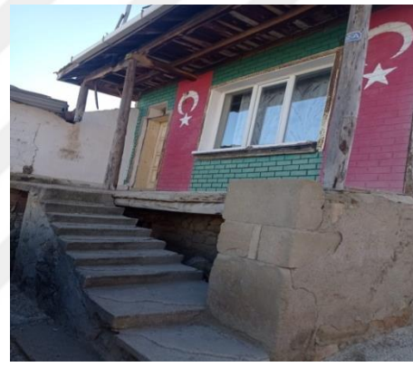
Resim 3.100. Odanın Batı Cephesi
