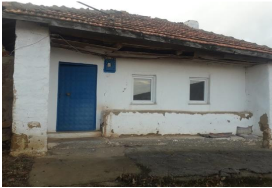
Resim 3.48. Odanın Batı Cephesi
