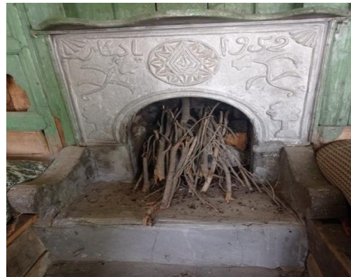
Resim 3.39. Odanın Ocaklık Kısmı
