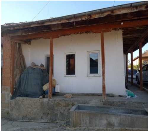
Resim3.70. Odanın Batı Cephesi
