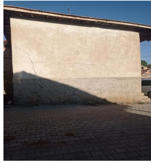
Resim3.112. Odanın Doğu Cephesi
