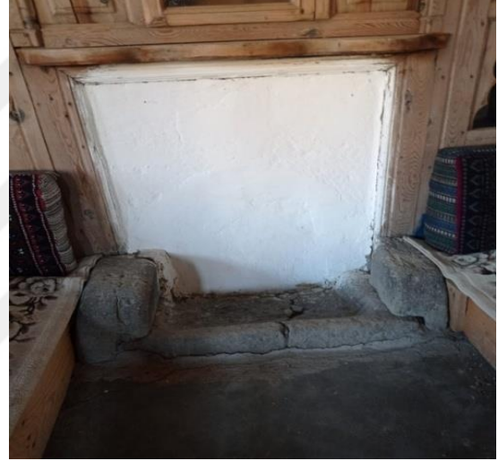
Resim 3.80. Odanın Ocaklık Kısmı
