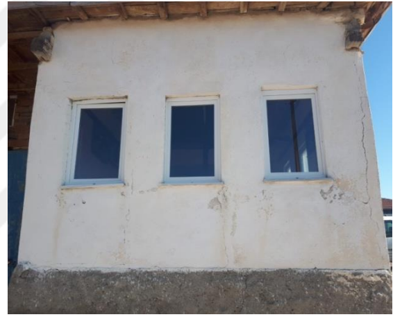
Resim 3.89. Odanın doğu Cephesi
