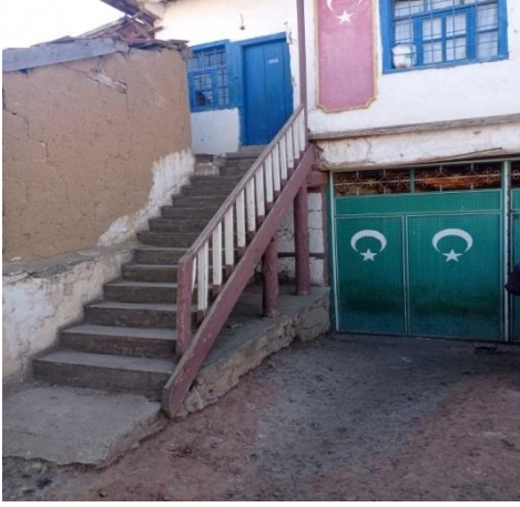
Resim 3.130. Odanın Batı Cephesi
