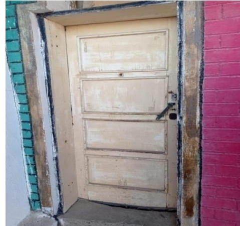
Resim 3.102. Odanın Giriş Kapısı
