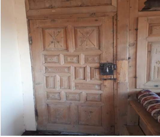
Resim 3.88. Odanın Giriş Kapısı
