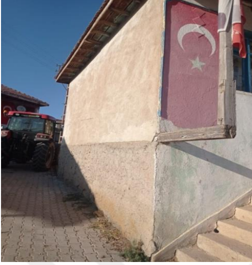
Resim 3.113. Odanın Güneydoğu Cephesi
