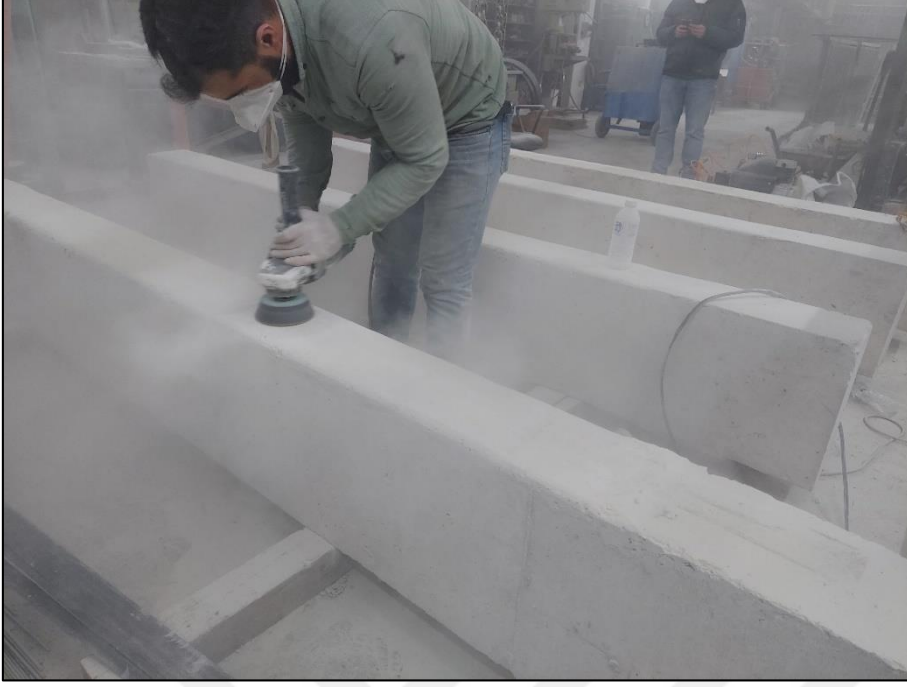
Resim 3.9. Beton yüzeyinin konik beton taşı ile silinmesi
