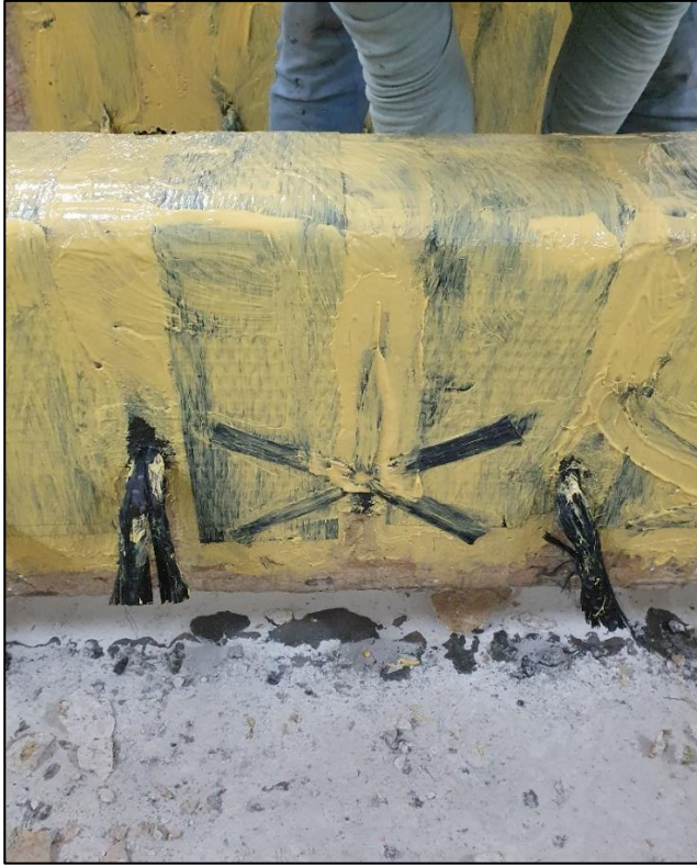
Resim 3.35. Karbon kumaşın kollara ayrılarak beton ve sargı yüzeyine yapıştırılması
