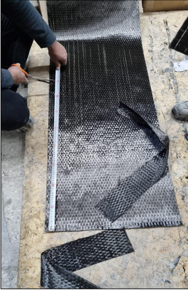
Resim 3.25. Karbon kumaşın kesilmesi
