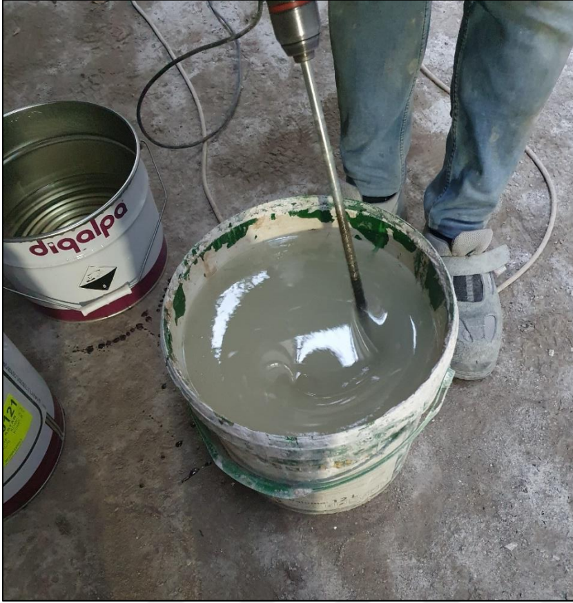
Resim 3.12. ift komponentli epoksi astarın A ve B bileşenlerinin karıştırılması
