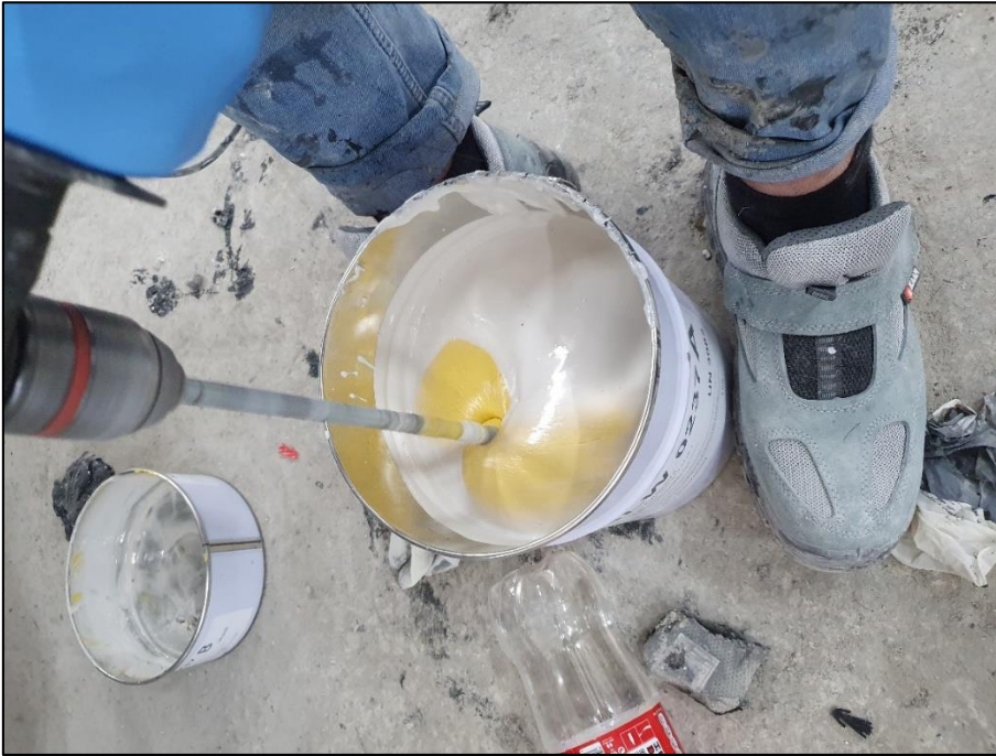
Resim 3.26. Epoksi Esaslı kumaş yapıştırıcı bileşenlerinin karıştırılması
