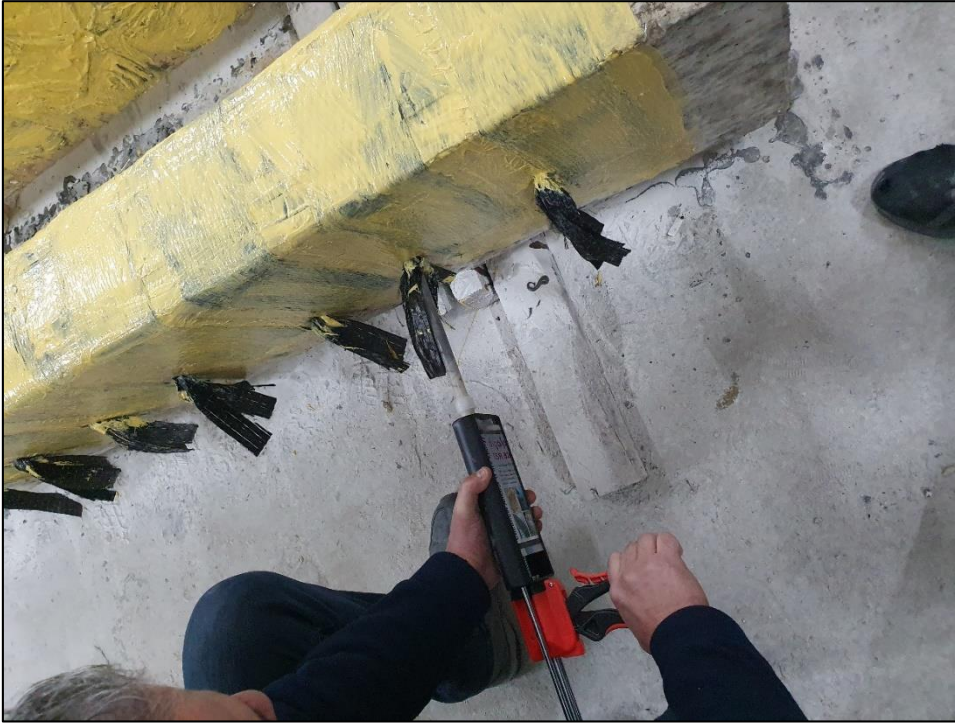
Resim 3.33. Ankraj deliklerine epoksi enjekte edilmesi
