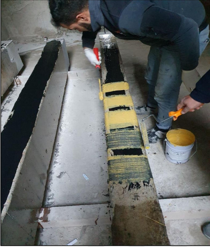
Resim 3.27. Karbon fiber kumaş yapıştırma işlemi
