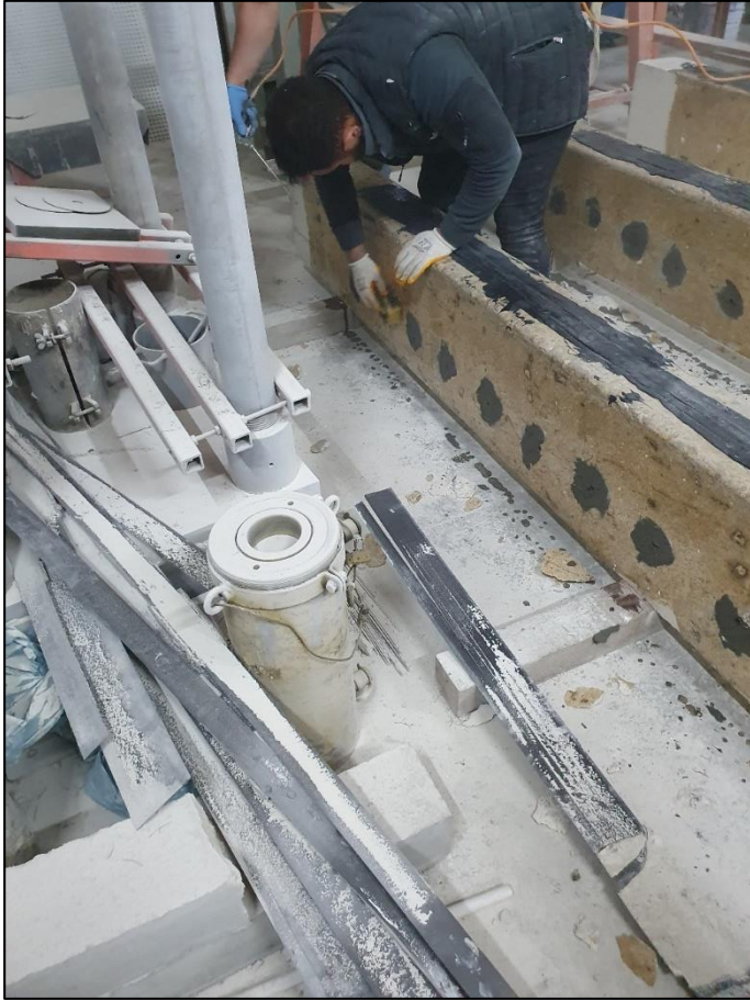
Resim 3.22. Yüksek mukavemetli tamir harcı uygulanan yüzeyler
