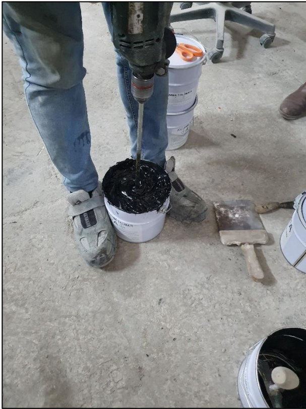
Resim 3.15. Epoksi esaslı plaka macunu komponentlerinin karıştırılması
