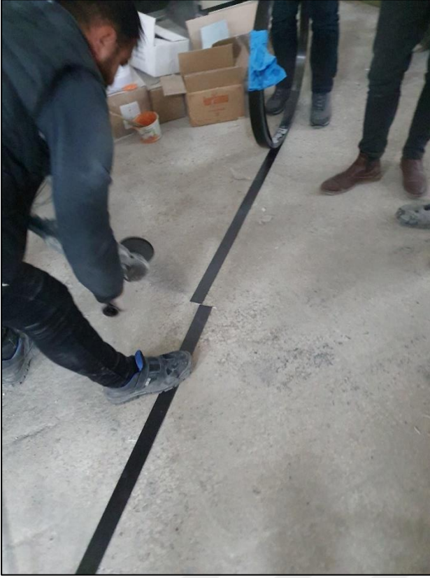
Resim 3.14. Karbon fiber plakannın rulosundan kesilmesi
