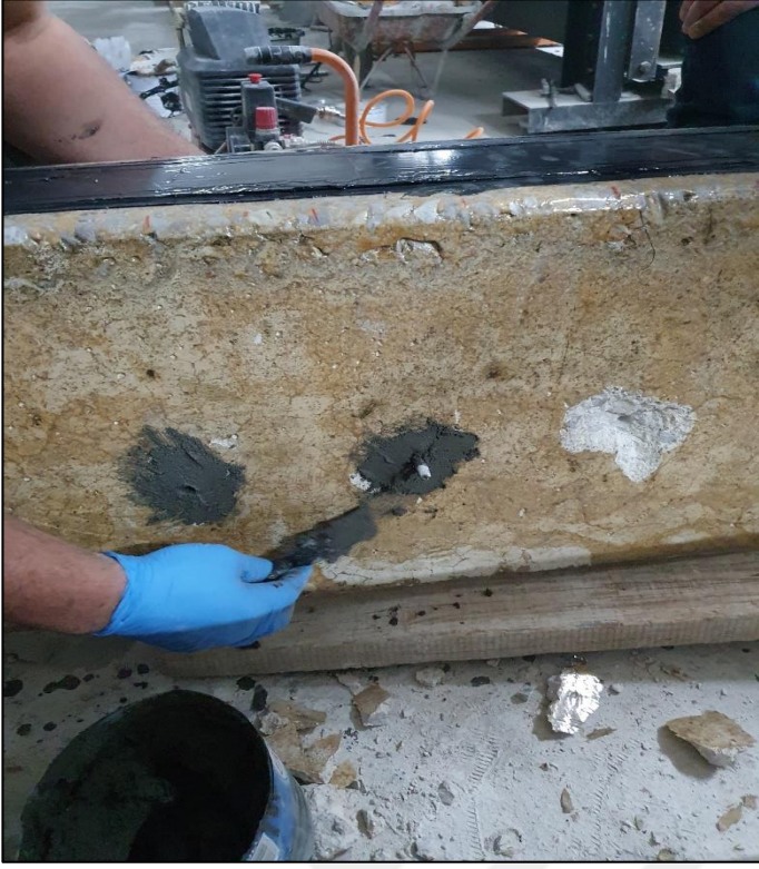
Resim 3.23. Deliklerin kapanmaması amacıyla yağ tamir harcı içerisinde tijle kanal açma
