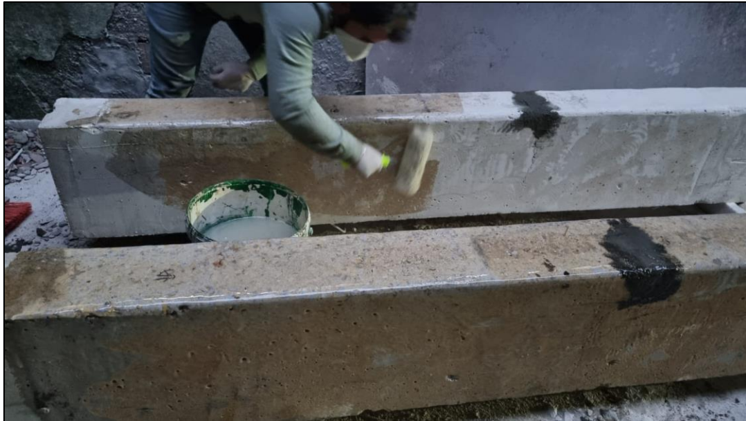
Resim 3.13. Epoksi astar uygulanması
