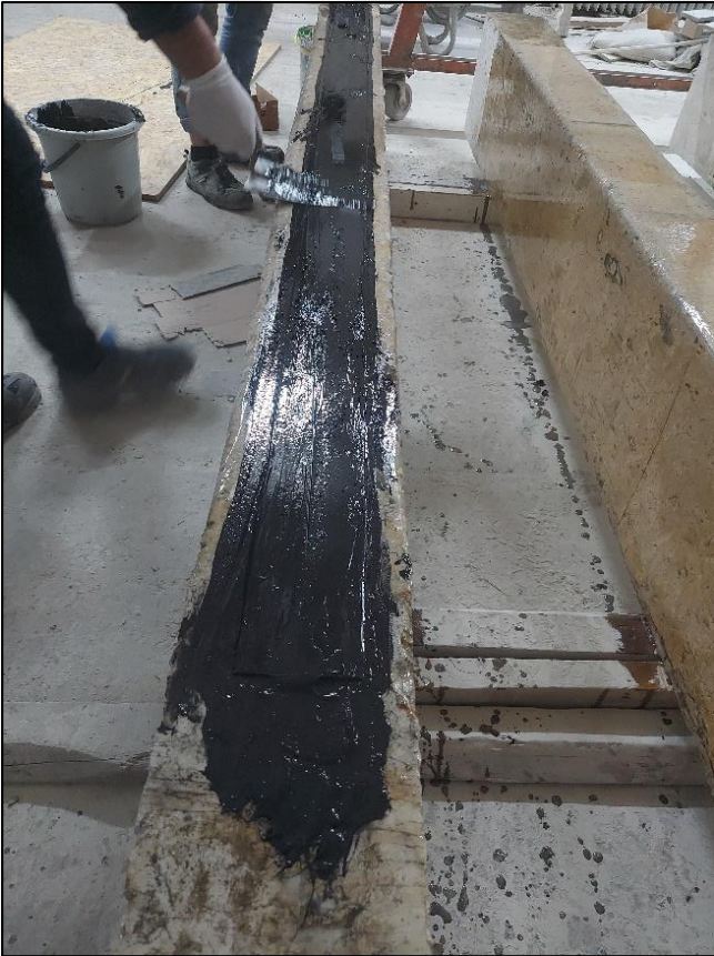
Resim 3.18. Epoksi macunla yüzeyi kapatılan plaka
