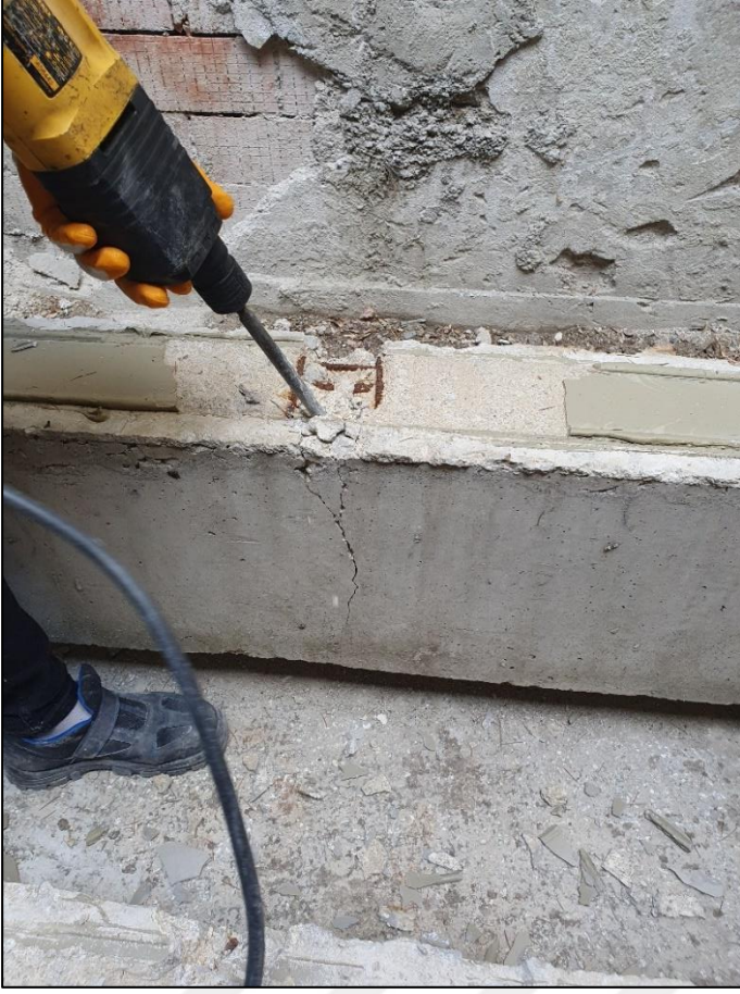
Resim 3.6. Yüzeyden kopan ve oynayan beton parçalarının kaldırılması
