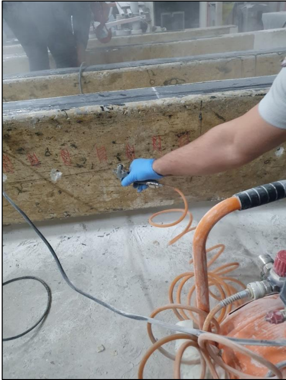
Resim 3.29. Ankraj deliklerinin tozdan arındırılması
