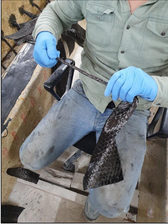
Resim 3.31. Karbon kumaşın ankraj deliğine yerleştirilmesi öncesinde kıvrılması
