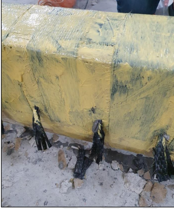
Resim 3.34. Ankragepoksi uygulamasında delik arka yüzeyinden taşan bağlayıcı
