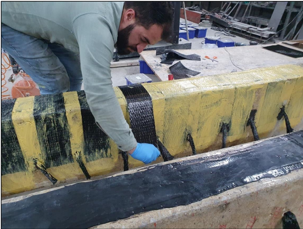
Resim 3.28. İkinci kat karbon fiber kumaş uygulanması
