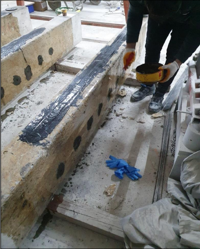
Resim 3.24. Onarılan yüzeylere epoksi astar sürülmesi
