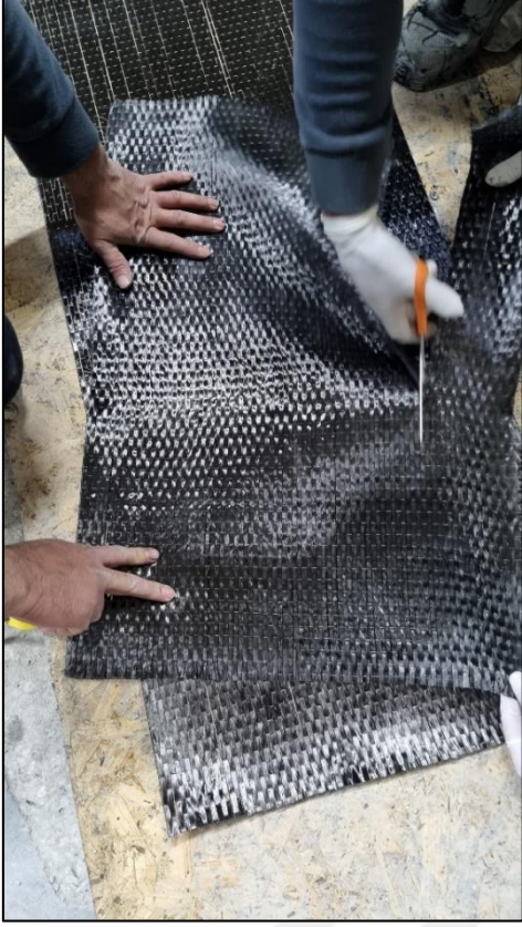
Resim 3.30. Ankraj imalatı için karbon kumaş kesilmesi
