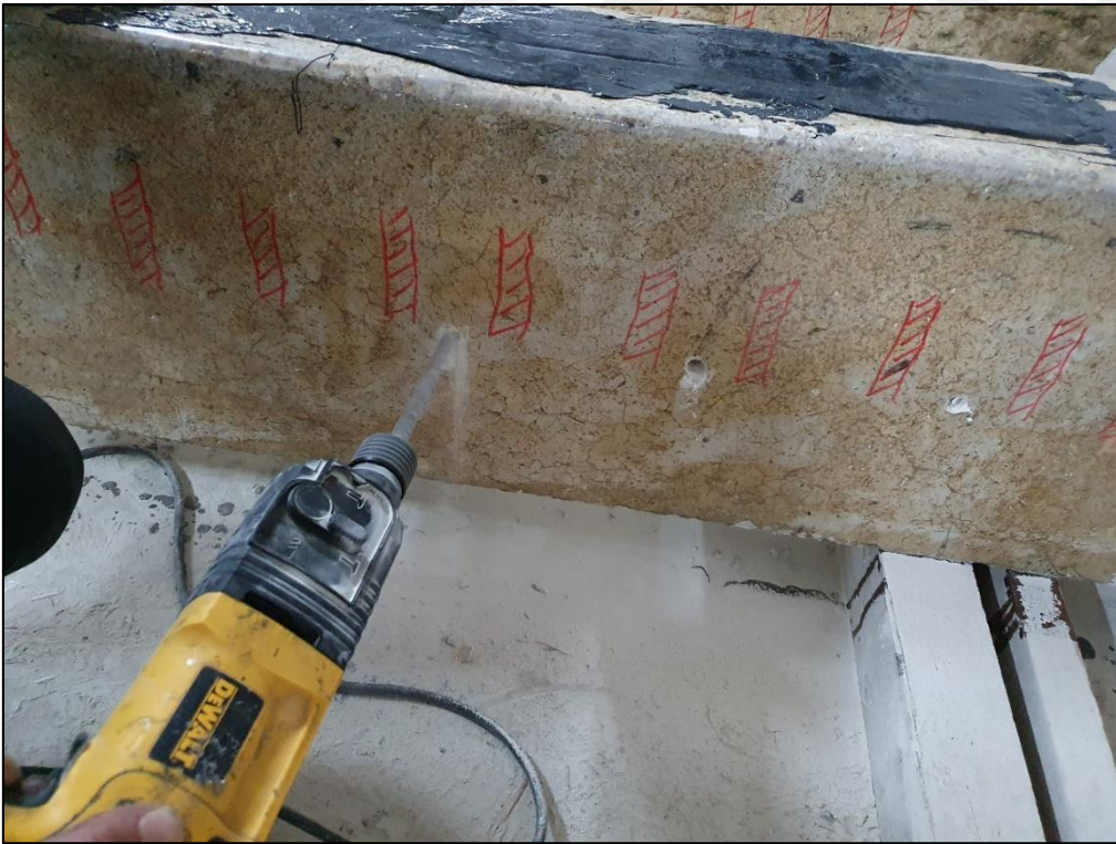
Resim 3.20. Ankraj deliklerinin açılması
