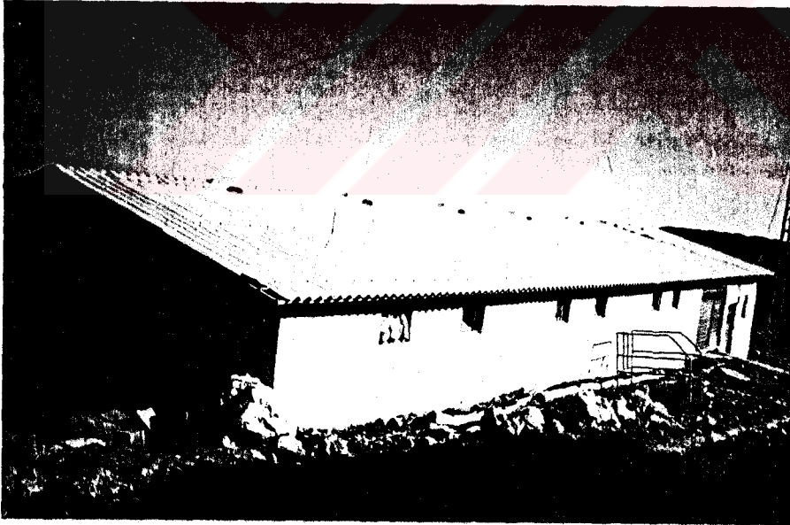
Resim 4. 8. Çatı örtü malzemesi olarak eternit kullanılan süt sığırclığı işletmesi
