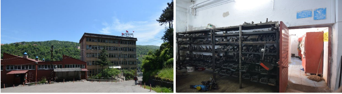
Şekil 5. 8: Kilimli Taşkömürü İşletme Müdürlüğü binası (24) ve soyunma-duşlar (57). Merve Varol Can, 2019.
