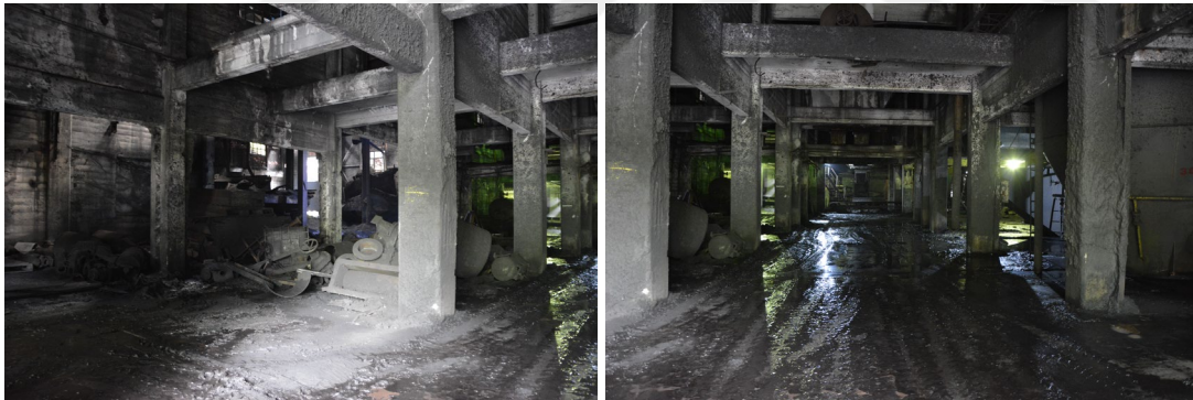
Şekil 5. 27: Lavuar alanı betonarme taşıyıcı kat. Merve Varol Can, 2023.
