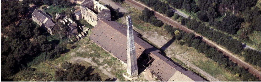
Şekil 4. 3: Nachtigall maden ocağı ve tuğla fabrikası 1963’ler. Route Industriekultur Resmî Web Sitesi, 2022.
