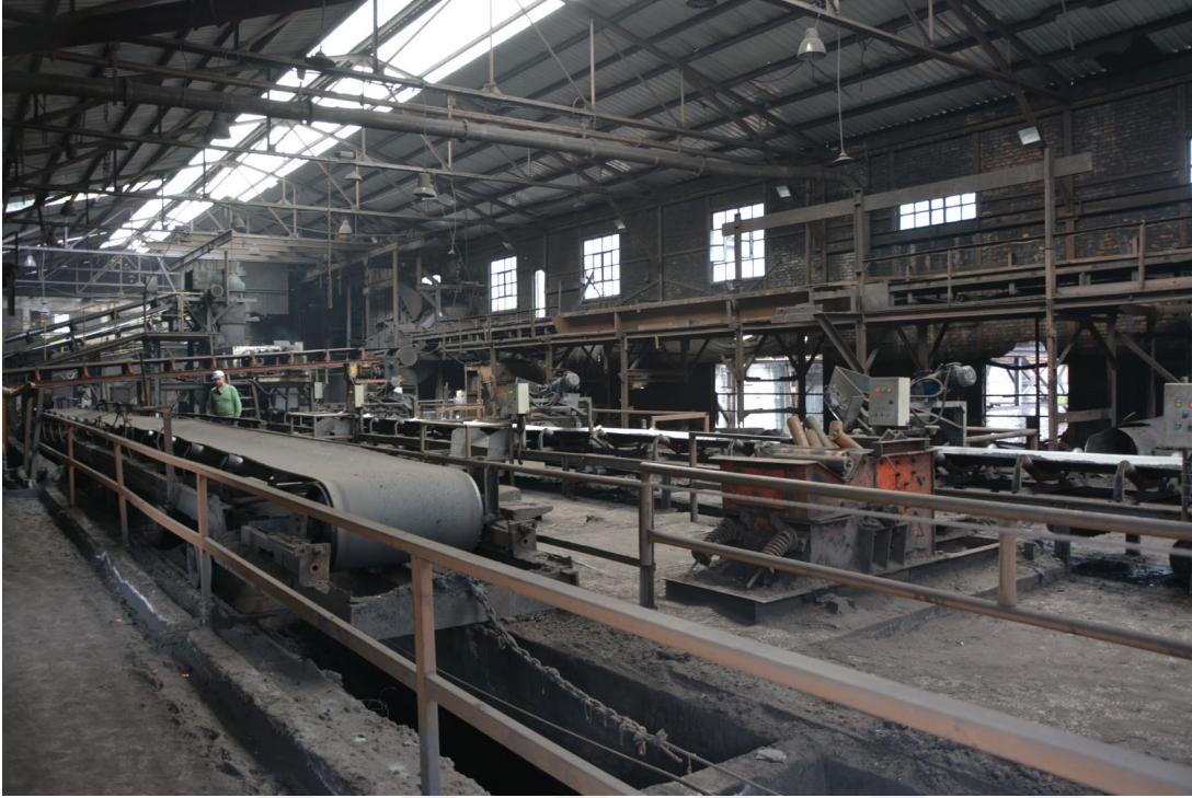
Şekil 5. 29: Temiz kömür silolarının yer aldığı kompleks (5) üzerinde siloları besleyen konveyör bantların yer aldığı çelik strüktürlü kat. Merve Varol Can, 2023.
