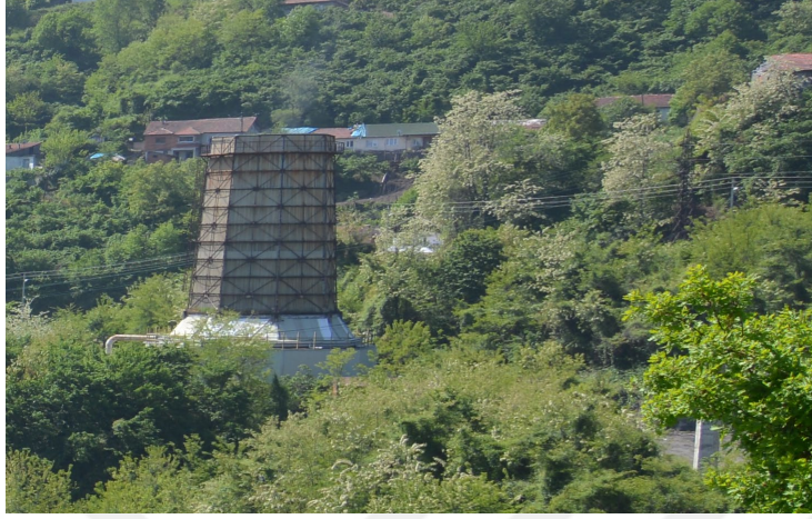
Şekil 5. 11: Soğutma kulesi (41). Merve Varol Can, 2019.
