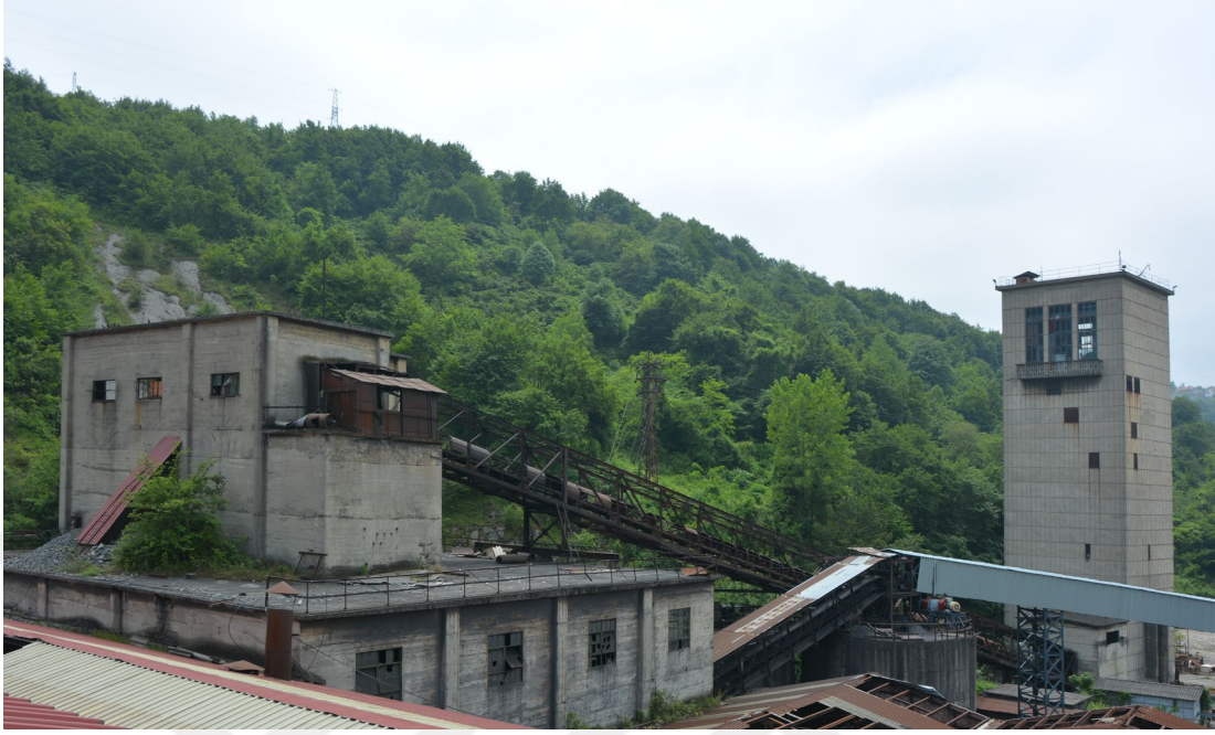
Şekil 5. 23: Kriblaj binası (sol) ve II nolu kuyu (sağ). Merve Varol Can, 2023.
