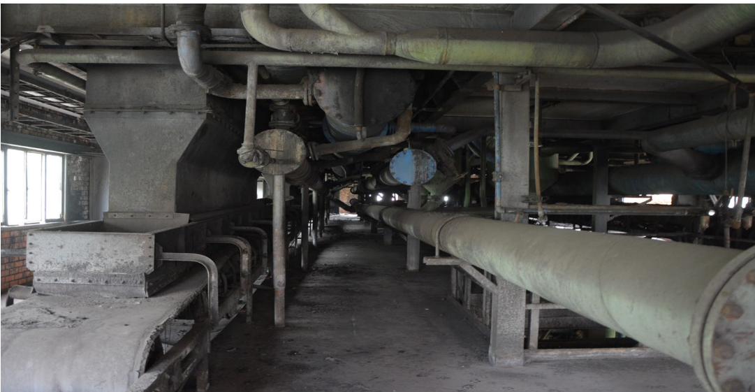
Şekil 5. 35: Filtrasyondan çıkan filtre keki denilen toz artıkların toplandığı kat. Merve Varol Can, 2023.
