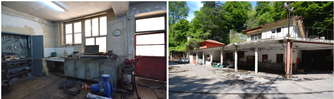
Şekil 5. 7: Eski işletme binası (68). Merve Varol Can, 2019.
