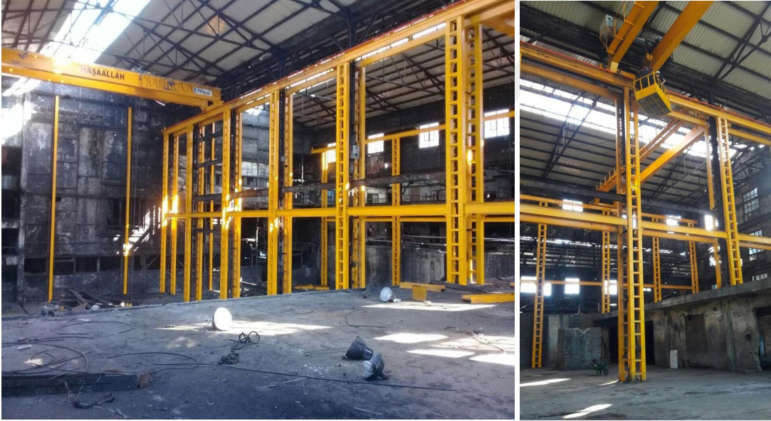
Şekil 5. 25: Çatalağzı lavuarı modernizasyon. TTK Arşivi.
