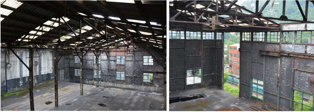
Şekil 5. 31: Eski flotasyon tesisi. Merve Varol Can, 2023.
