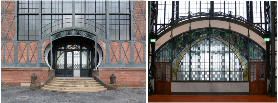
Şekil 4. 40: Zeche Zollern Art Nouveau giriş portalı (dış ve iç görünüm).
