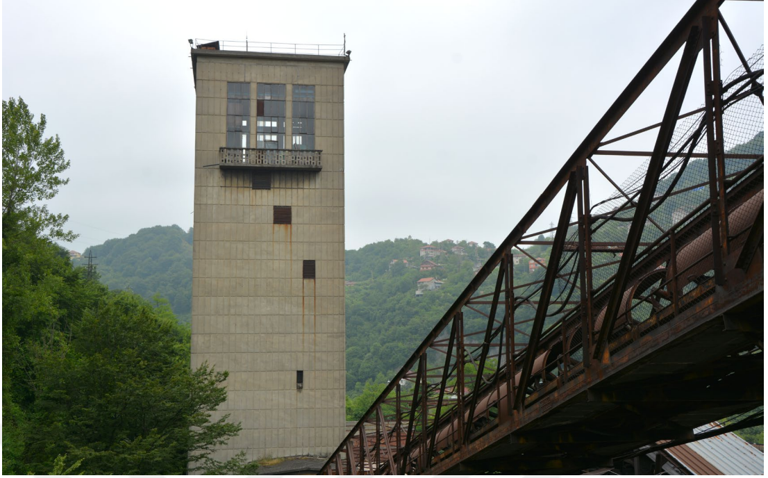
Şekil 5. 21: II nolu Çatalağzı kuyusu. Merve Varol Can, 2023.
