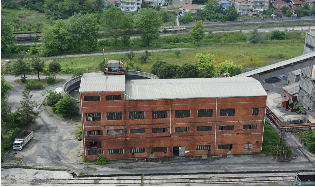
Şekil 5. 32: Eski filtrasyon tesisi ve arkasında yer alan tikiner. Merve Varol Can, 2023.
