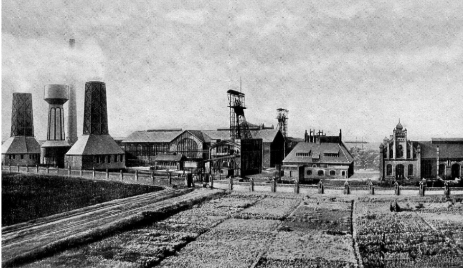
Şekil 4. 34: Zeche Zoller maden sahası II ve IV nolu kuyular.
