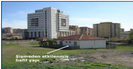
Şişmeden etkilenmiş hafif yapı
