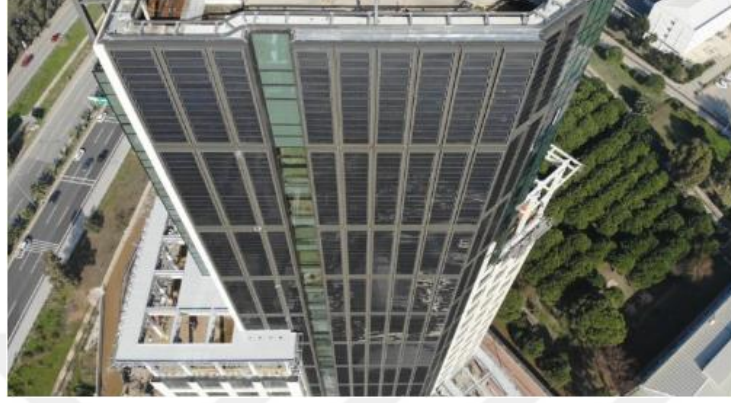
Şekil 2.49. BIPV (Binaya Entegre Fotovoltaik) GES Uygulama Örneği
