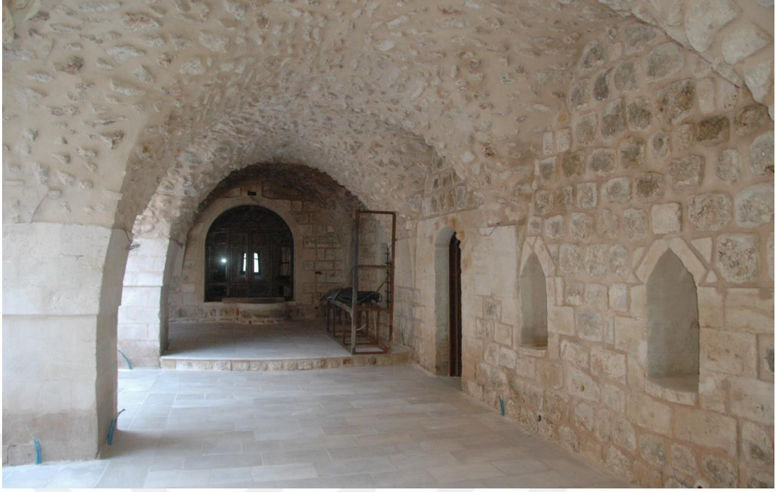
Şekil 2.8 : Avlu revakları (Irmak Restorasyon Ofisi)
