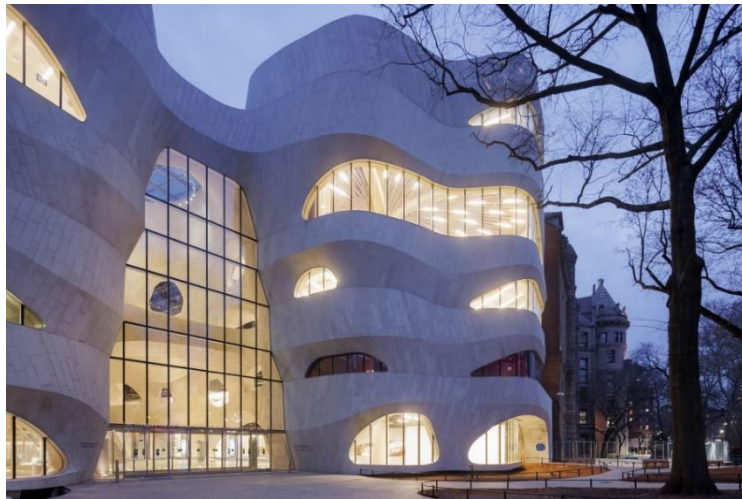
Şekil 5. 72: Püskürtme beton kullanılarak inşa edilen merkezin cephesi, Milford Pembe Granit ile kaplanmıştır.
