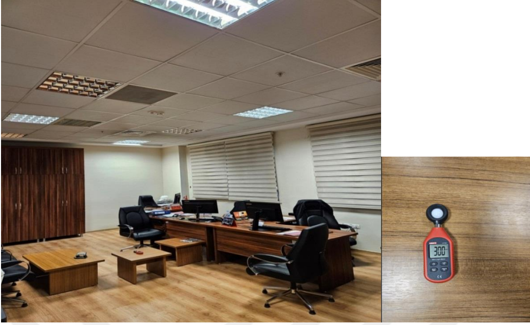
Şekil 3.2 300 Lüks üzeri aydınlatma yapılan çalışma ofis örneği
