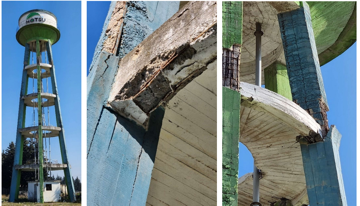
řekil 2.5. Adana-Hatay Yolu Antakya ayaklı su deposu
