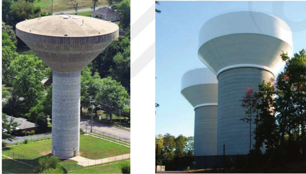
Şekil 1.4. Kabuk taşıyıcı sisteme sahip sırası ile betonarme ve kompozit ayaklı su depoları (ACI 371R-16)
