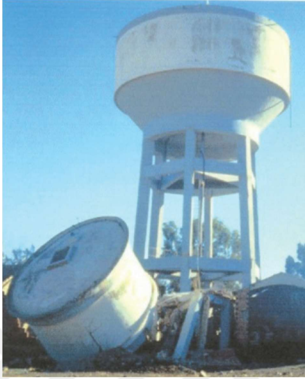
Şekil 2.3. 1980 Cezayir El-Asnam depremi ayaklı su deposu (PEER)
