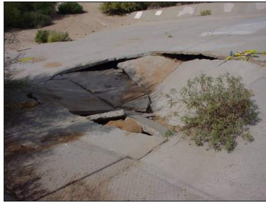
Şekil 1.6 : Yapısal çökme.
