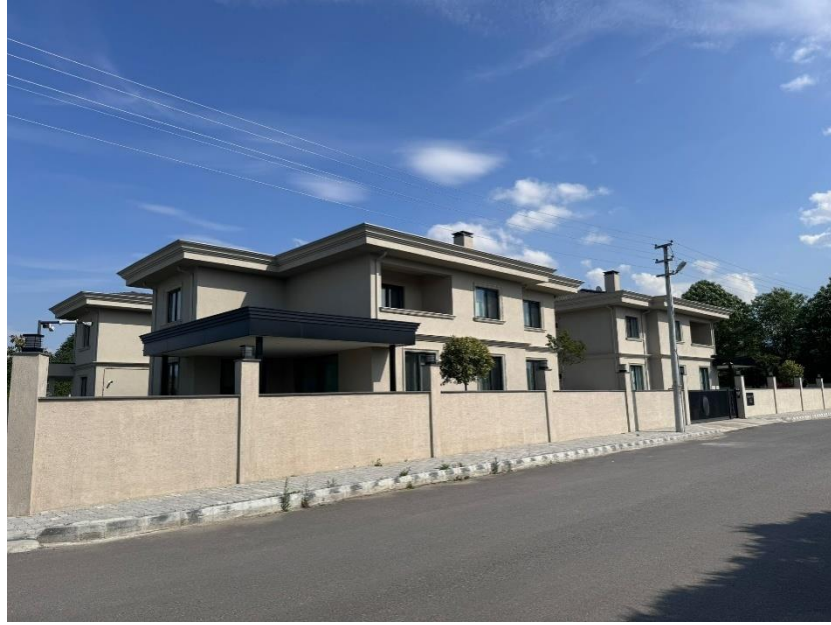
Şekil 6.34.4. Bölge gelişme konut alanı kapalı site örneği.
