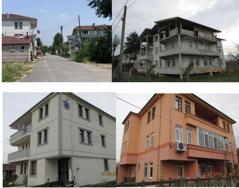
Şekil 6.28. 3. bölge eklentili ve 3 katlı yapı örnekleri.
