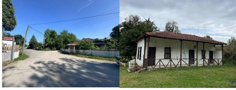
Şekil 6.19. 1. Bölge geneleksel konut yapısı ve sokak görüntüsü.
