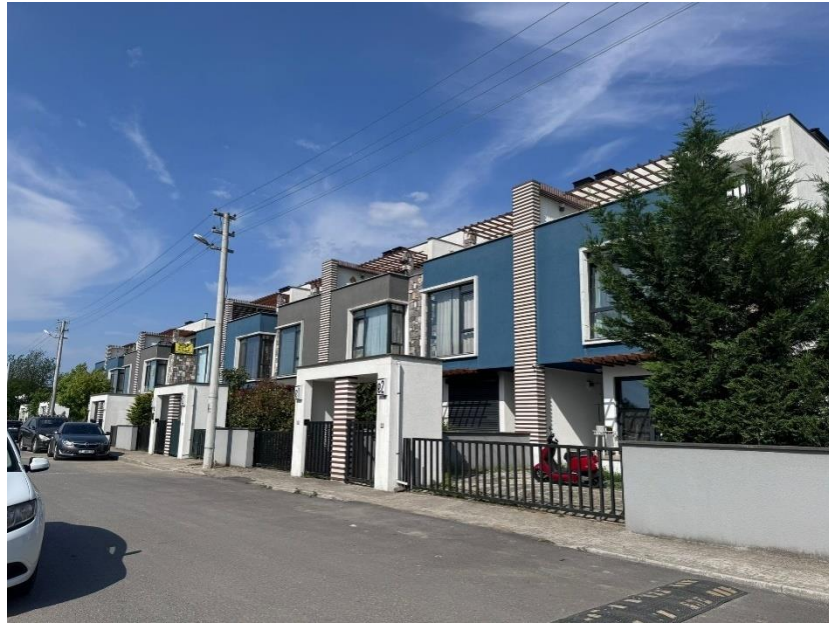
Şekil 6.35. 4. Bölge gelişme konut alanı kapalı site ve blok yapılaşma örnekleri.
