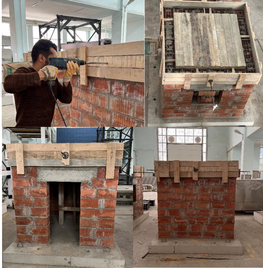
Şekil 6.25. Donatısız yığma yapıda döşeme ve kiriş kalıplarının montajı
