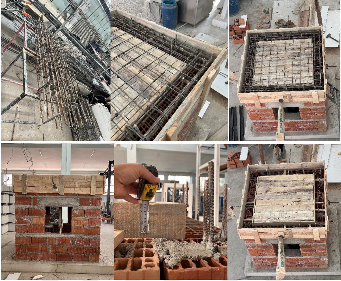
Şekil 6.19. Döşeme ve kirişlerde kalıp ve donatı montajı
