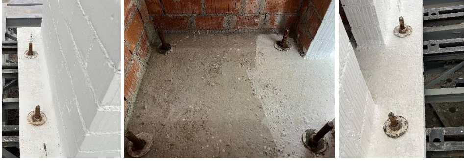
Şekil 6.34. Yığma yapı numunelerinin sarsma tablasına sabitlenmesi
