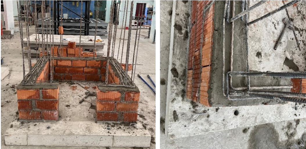
Şekil 6.17. Donatılı yığma yapıda yatay donatıları yerleştirilmesi
