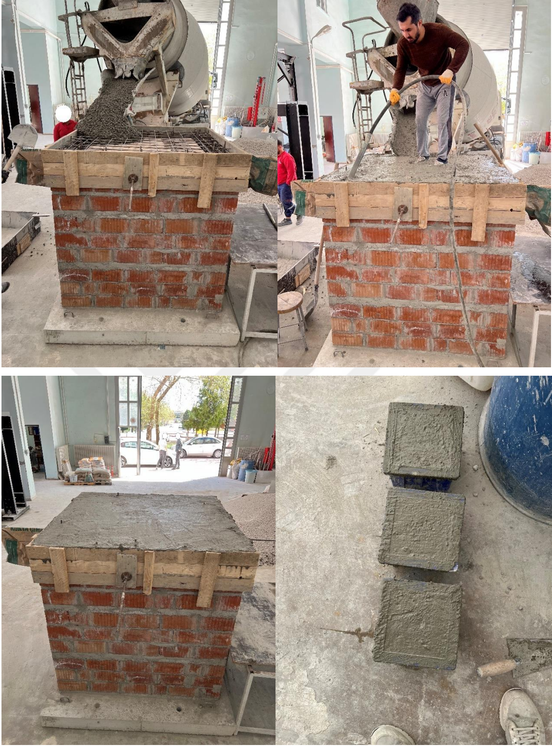
Şekil 6.20. Donatılı yığma yapıda döşeme ve kiriş betonu dökümü
