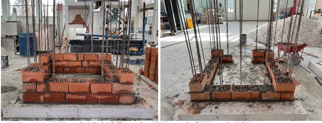
Şekil 6.16. Donatılı yığma yapıda duvar örülmesi
