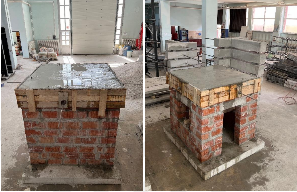
Şekil 6.21. Betonun kürlenmesi
