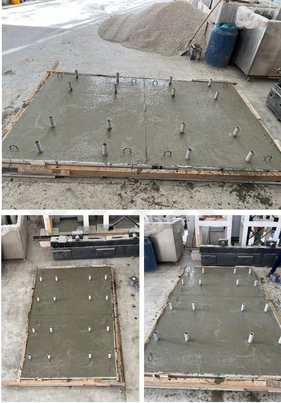
Şekil 6.14. Temellerin beton dökümü sonrasındaki hali
