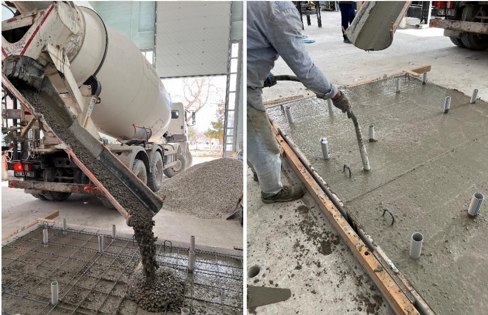
Şekil 6.13. Temelerde beton dökümü ve vibratör kullanımı
