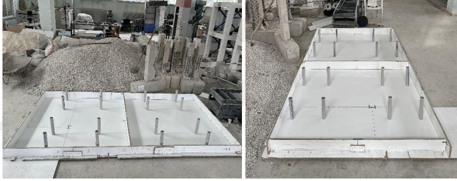
Şekil 6.11. Temel kalıplarına plastik PVC boruların yerleştirilmesi
