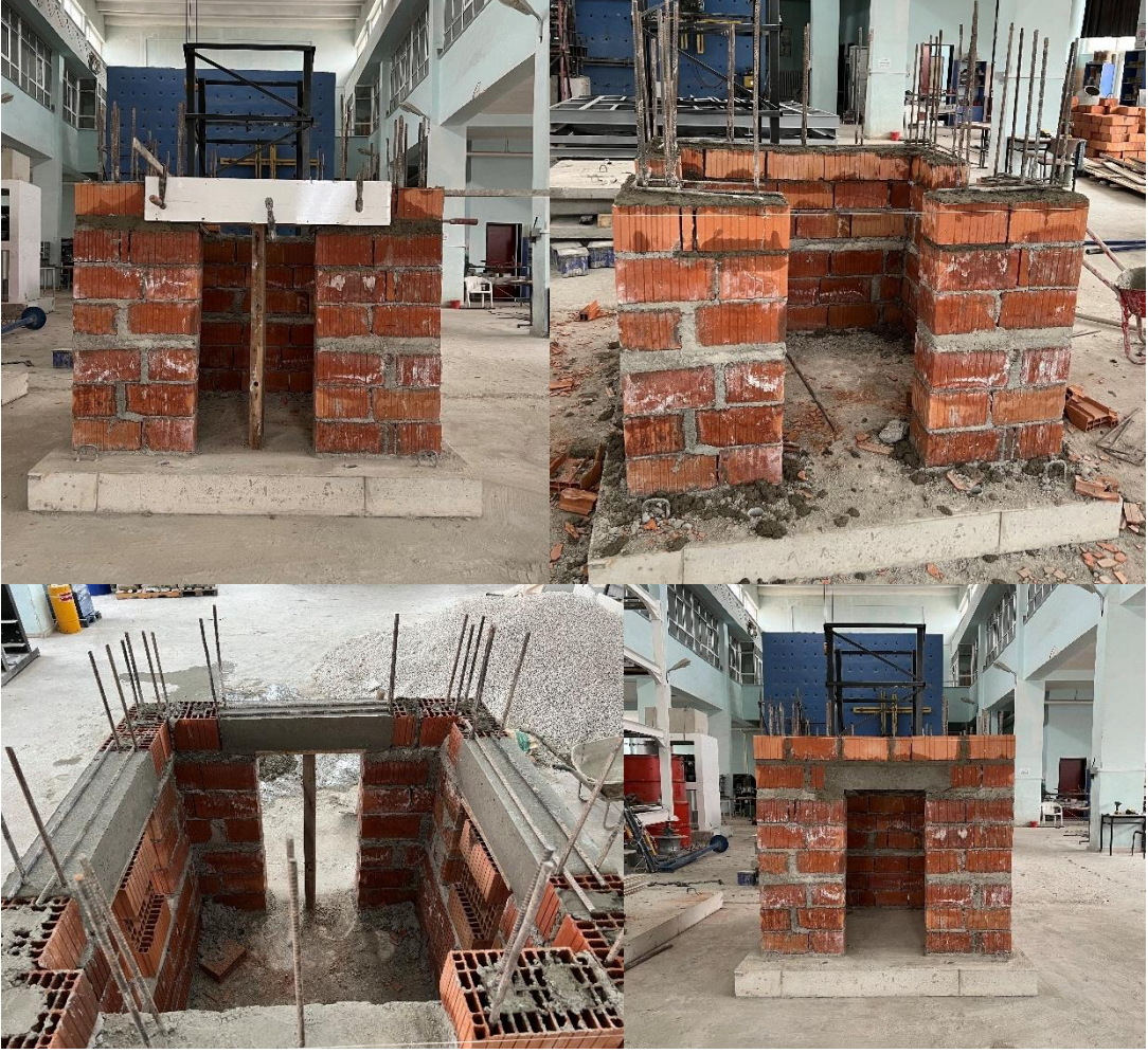
Şekil 6.18. Donatılı yığma yapı duvarlarının inşası
