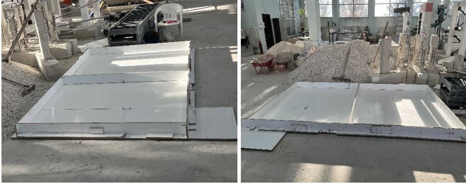
Şekil 6.10. Temeller için hazırlanan kalıplar
