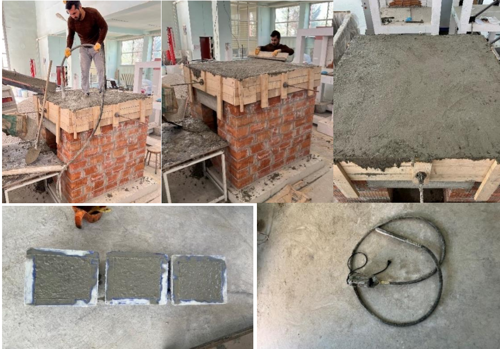
Şekil 6.27. Beton dökümü, alınan numune ve vibratör cihazı
