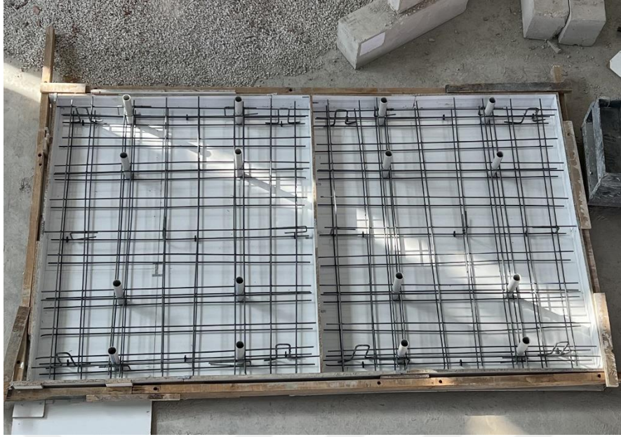
Şekil 6.12. Temellerin donatı imalatı ve kalıpların güçlendirilmesi
