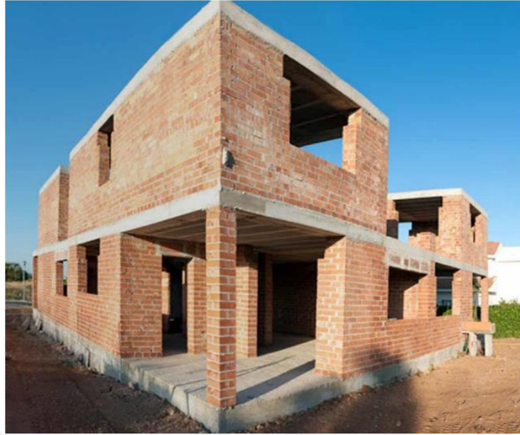
Şekil 3.1. Donatısız yığma yapı (Ersubaşı, 2008)
