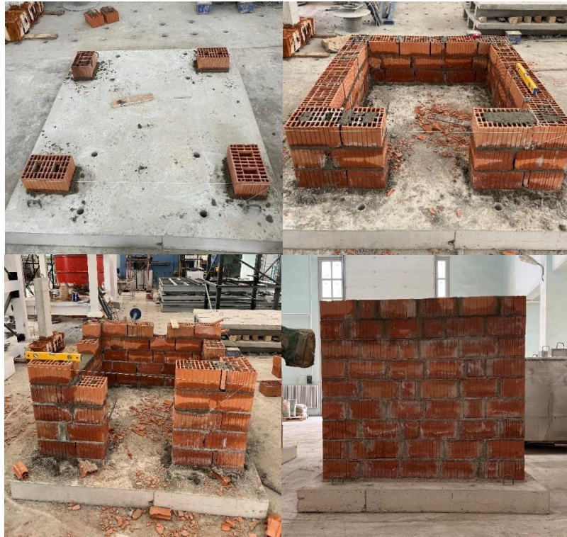
Şekil 6.24. Donatısız yığma yapının duvarlarının örülmesi
