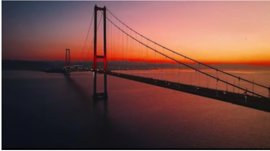
Görsel 6. Osmangazi Köprüsü
