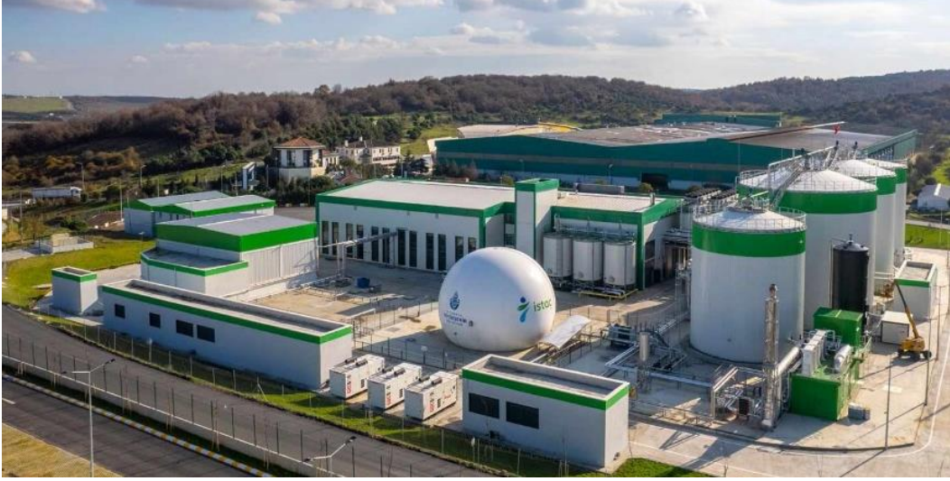
Şekil 3.3 Kemerburgaz biyometanizasyon tesisi [63]
