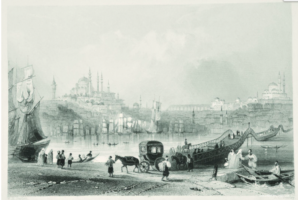
Şekil 5.20 1836 yılında Unkapanı-Azapkapı arasına inşa edilen köprü (Bilsel, 2015: 497)
