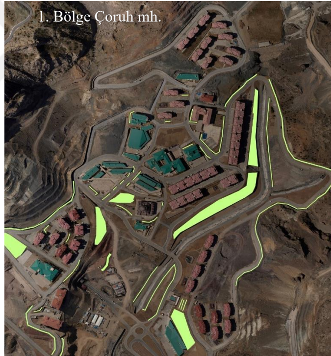
Şekil 96. 1. Bölge Çoruh mh. bitkilendirmenin yoğunlukta olduğu alanlar (Foto: T. MEYDAN)
