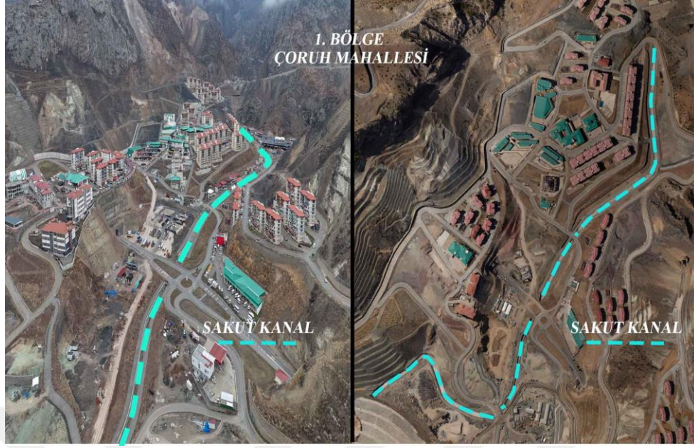
Şekil 123. Sakut su kanalının Yusufeli yeni yerleşim alanındaki geçiş güzergahına ilişkin drone görüntüsü (Foto: T. MEYDAN)
