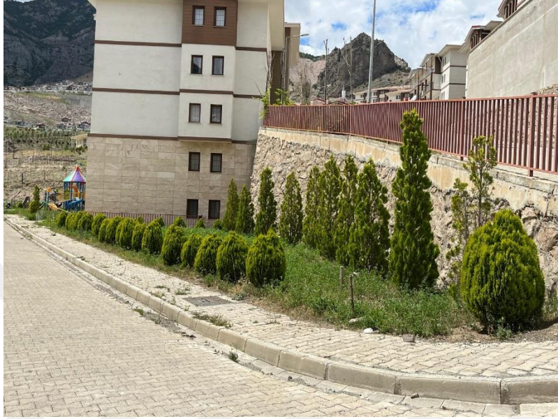
Şekil 108. İstinat duvarı ve duvar önü bitkilendirme (Foto: T. MEYDAN)
