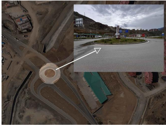
Şekil 114. 1. Bölge (Çoruh mh.) de yer alan kavşak (Foto: T. MEYDAN)
