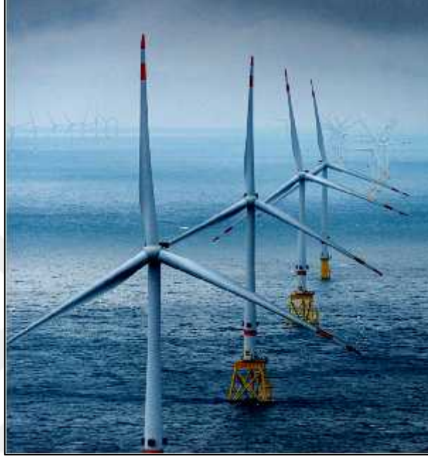
ekil 4.1. 900 MW kapasiteli Vestas-Bakum Riffgrund açık deniz rüzgar santrali
