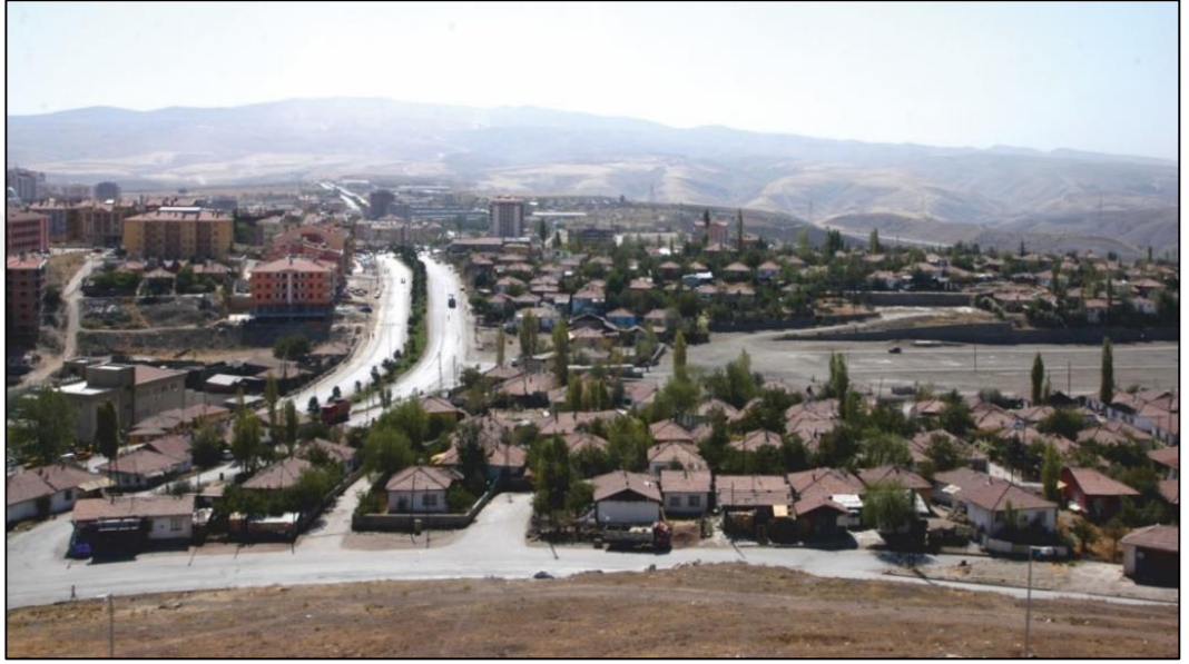
Şekil 5.9 Ege Mahallesi kentsel dönüşüm öncesi (Anonim 2024s)
