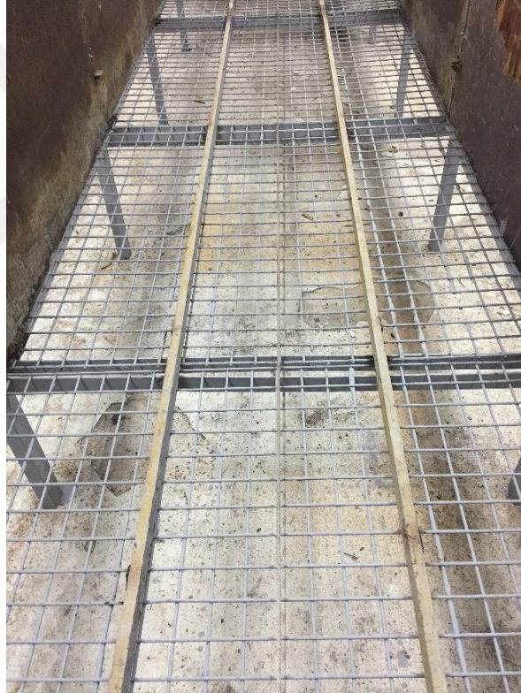
Şekil 3.7 : Reaktör tabanında bulunan ızgara yapı.
