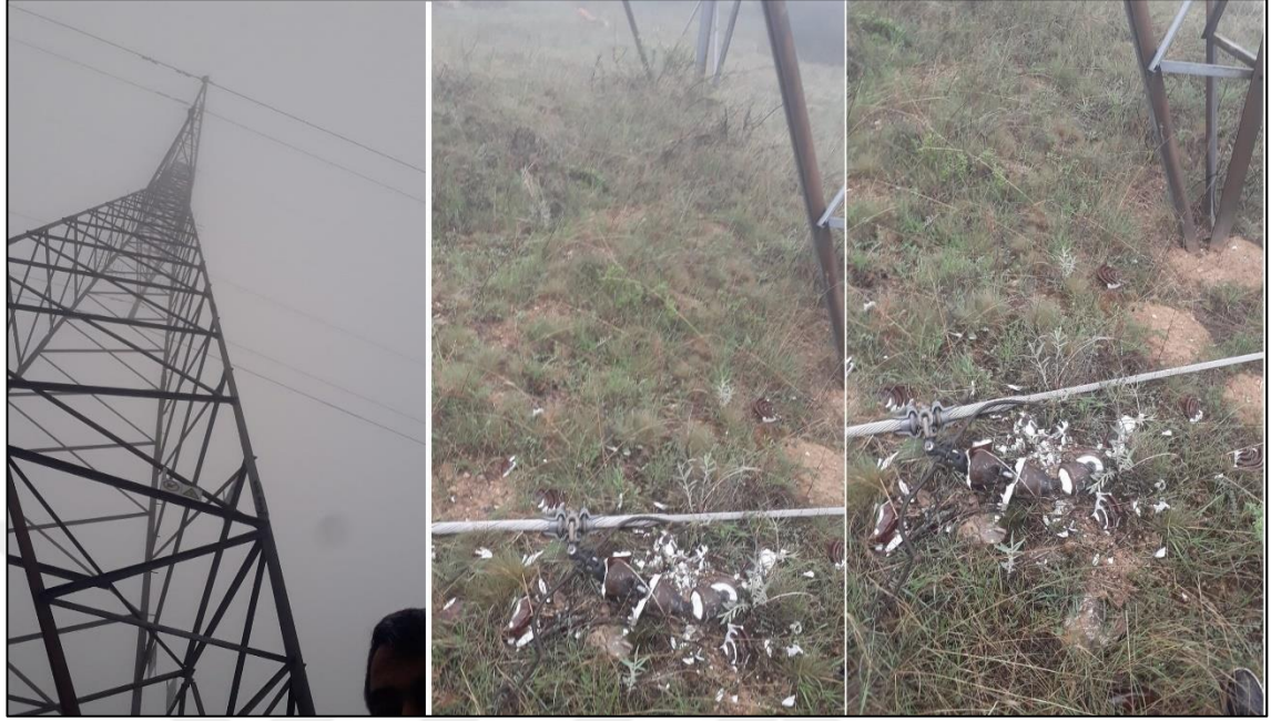
Şekil 4.17. 154 kV Sincan-Balgat hattına 289,12 m uzaklıkta boş arsaya düşen YEMD’in kublaj etkisine bağlı iletkenin bağlı olduğu izolatörün parçalanması (2024)
