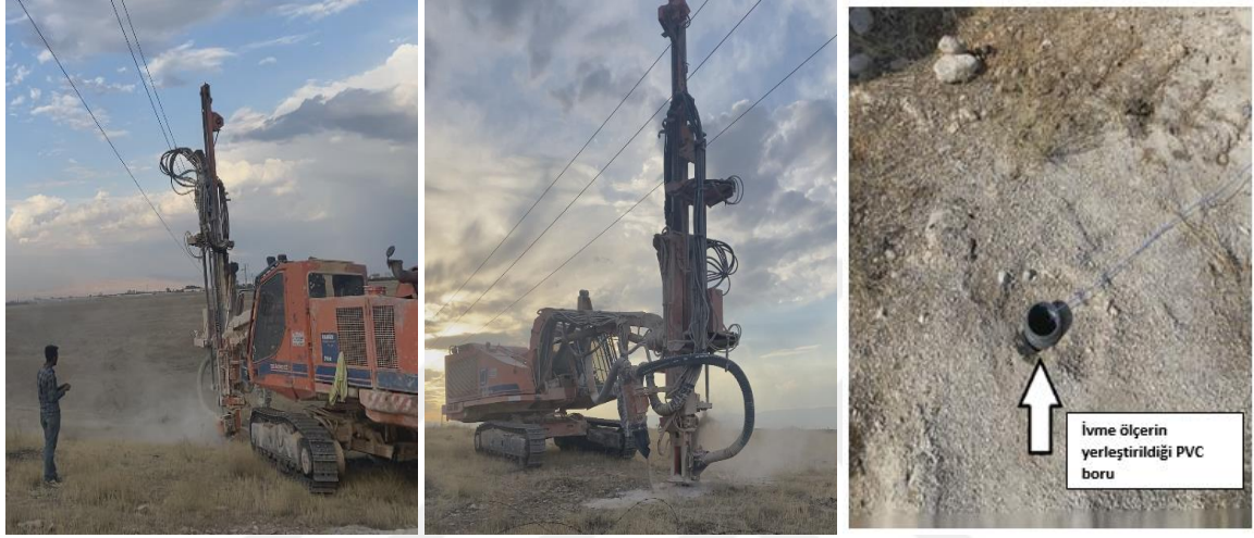
Şekil 3.3. Burgu Makinası Tamrock Ranger 780 ile deney sahasında yapılan delme işlemi ve ivme ölçer yerleştirilmesi
