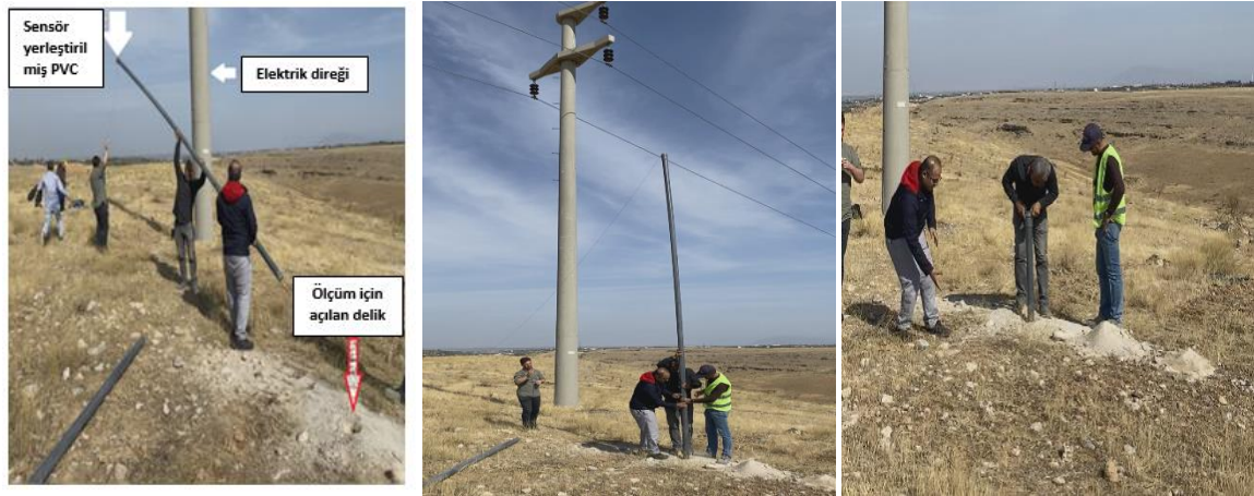
Şekil 3.4. İvme ölçerin açılan deliklere yerleştirilme işlemi
