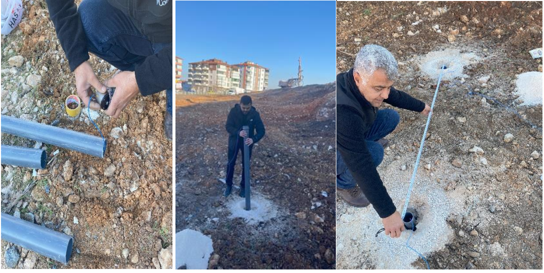
Şekil 3.9. İvme ölçerlerin sahaya yerleştirilmesi
