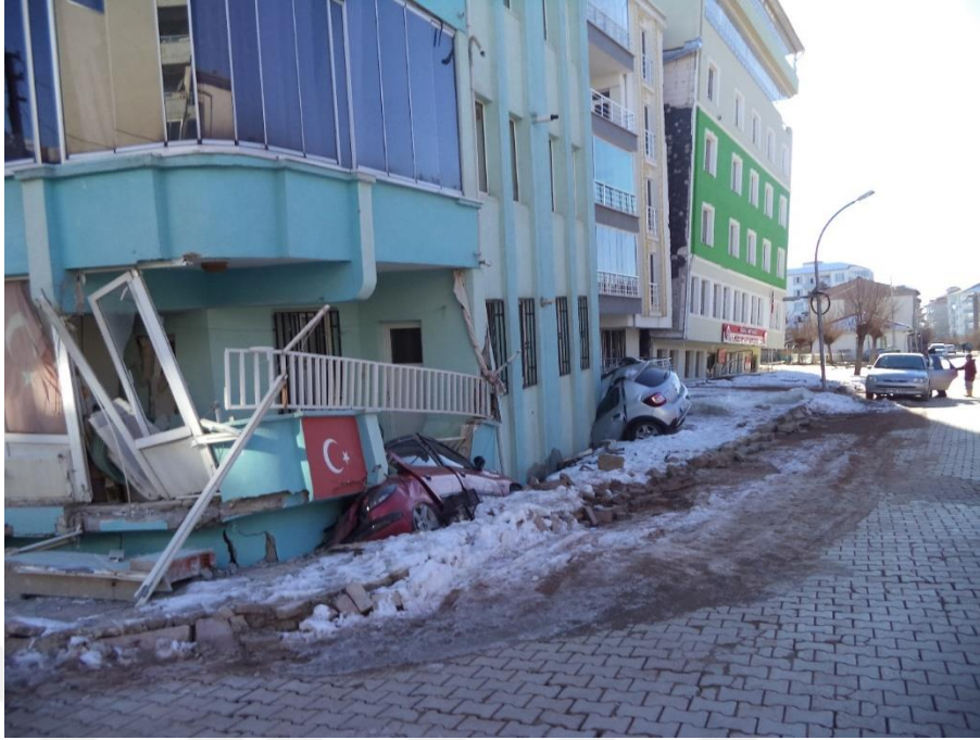
Şekil 1.2 Gölbaşı (Adıyaman) 6 Şubat'ta bina bütünlüğü bozulmayan ama zemine gömülüp tiltlenen bir bina (dış cephesi koyu yeşil bina) (İskender Dölek arşivi).
