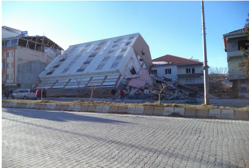
Şekil 1.1 Gölbaşı (Adıyaman) 6 Şubat'ta tiltlenen bir bina (İskender Dölek arşivi)
