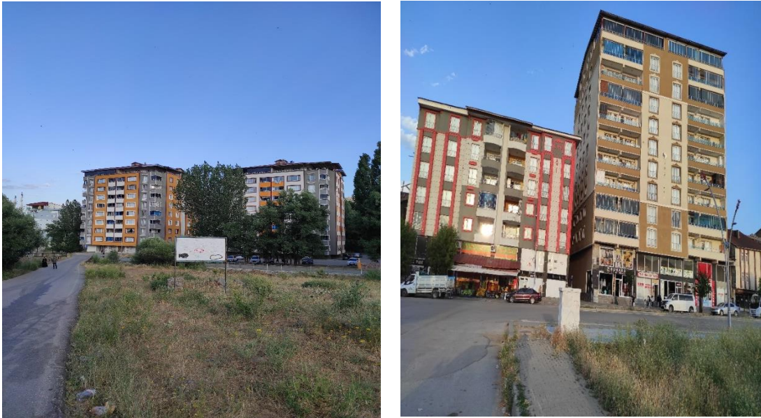
Şekil 1.4 Ağaçlı mevkiinde dere yatağı içerisine, İstasyon Mahallesinde alüvyon zemin üzerinde yeralan çok katlı binalar
