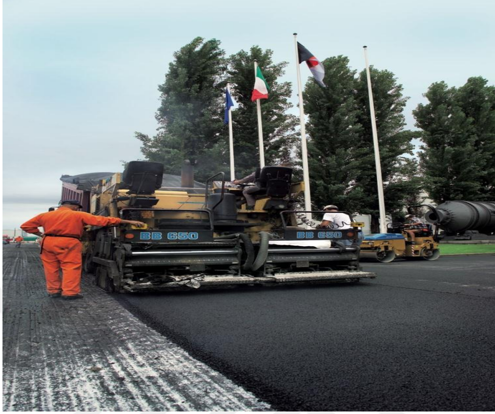
Şekil 2. 22. Karayolunda asfalt malzemesi olarak cürufun kullanımı
