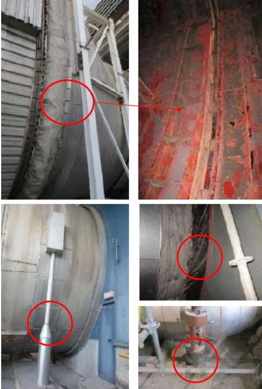
Resim 5.23. Türbin çıkış kompensatörü [7]
