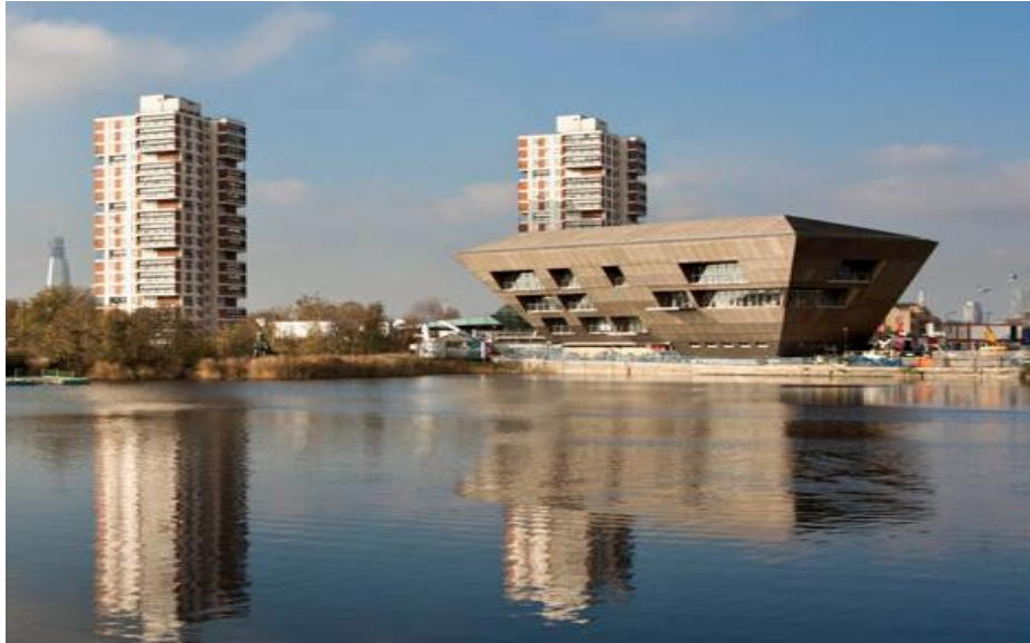
Şekil 2.13: Kanada Su Kütüphanesi
