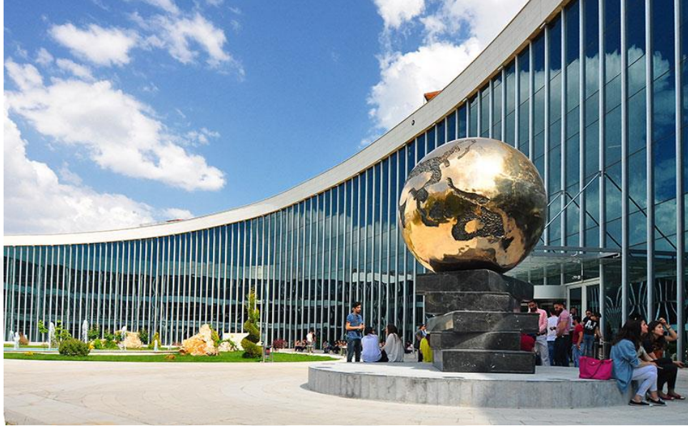
Şekil 3.4: Bina Dış Cephesi
