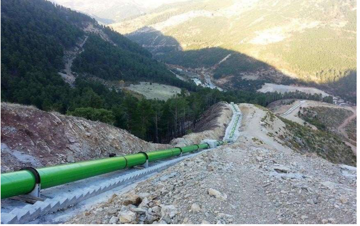
Şekil 3. 7 Bir tesisin cebri boru hattı
