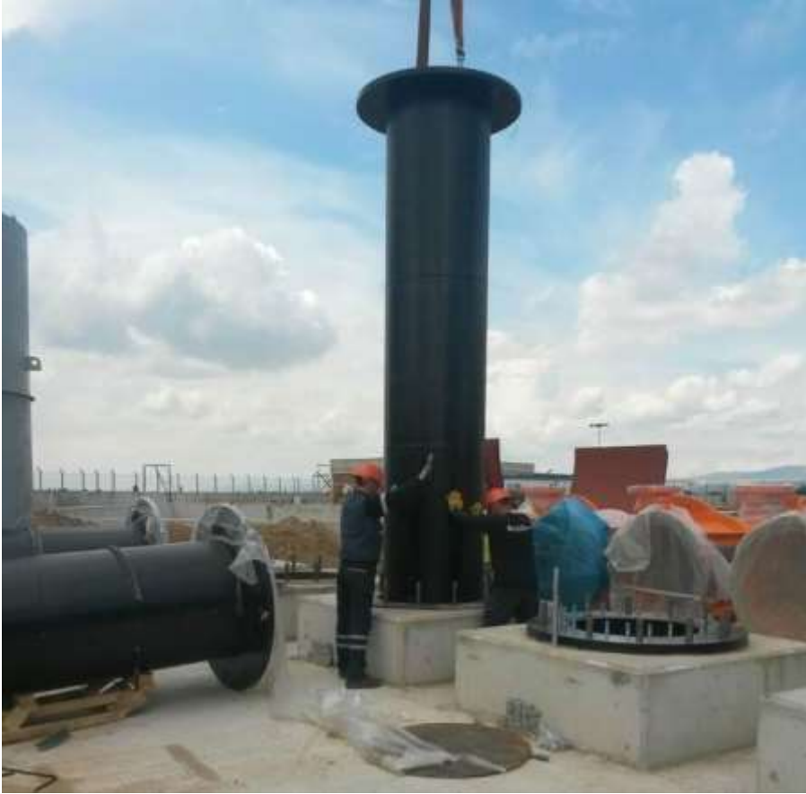
Şekil 4. 9 Yer altı salınım kuyusu montajı
