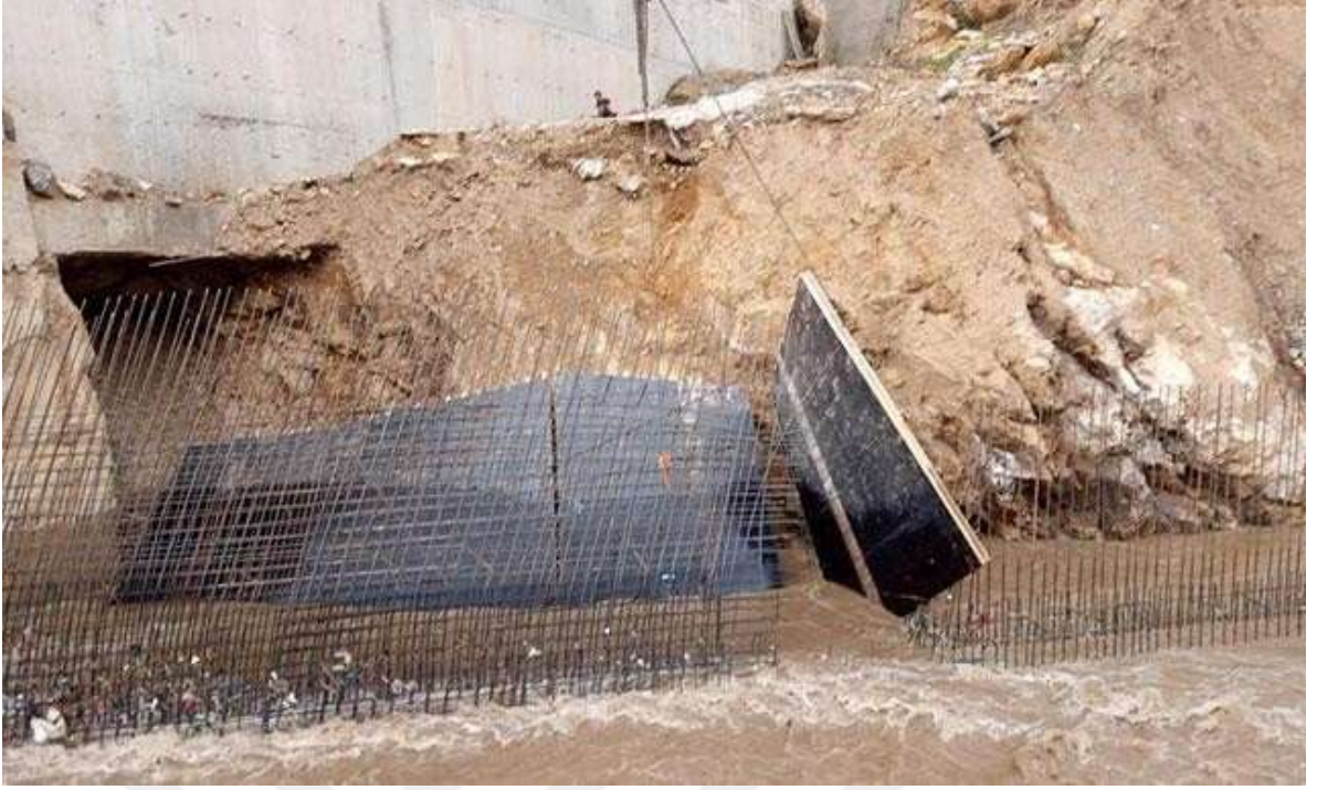
Şekil 4. 5 Kapağı açılan HES ve sonrasında oluşan sel
