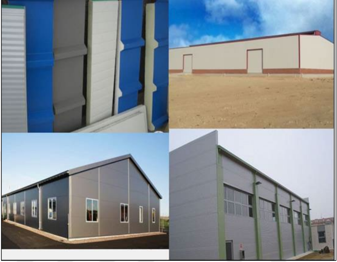
Şekil 4.16: Prefabrik yapılarda sandviç kompozit malzeme kullanımı
