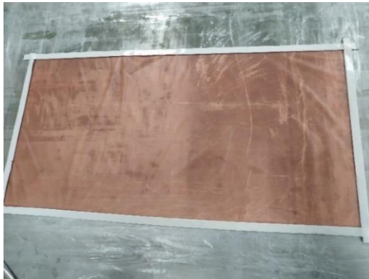
Şekil 3.5. Kalıp ayırıcı film ve sızdırmazlık bandının zemine yerleştirilmesi
