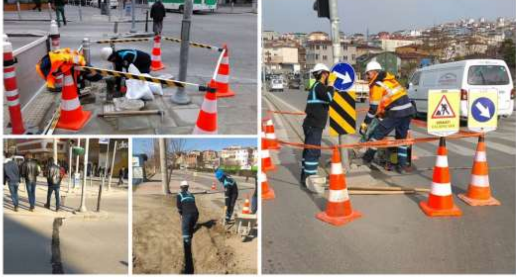
Şekil 6.4. Kocaeli Gebze ve Başiskele ilçelerinde Loop Döngü Kurulumu (Saha Çalışmalarından)
