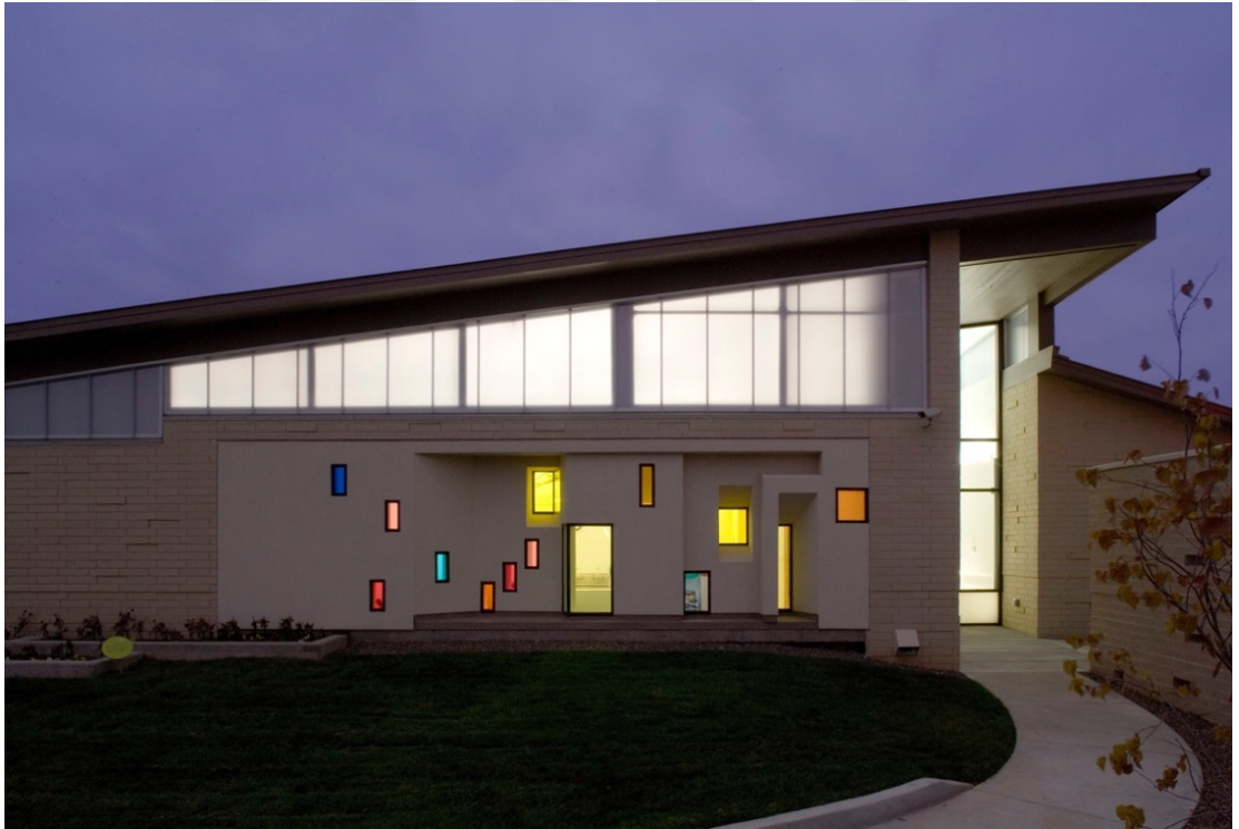
Şekil 4. 36: Bağlantı Merkezi Cephesi.
