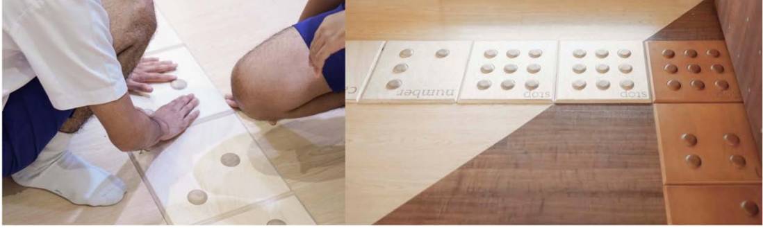
Şekil 4. 27: Görme Engelliler Sınıfı Zemin Detayı.
