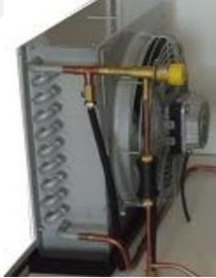
Şekil 10. Sistemde kullanılan hava soğutuculu evaporatör
