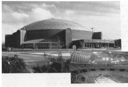
Şekil 1.10: 5xxx alaşım levha ile kaplanmış genellikle 6063 veya 6061 ekstrüzyon alaşımları kullanılmıştır [5].
