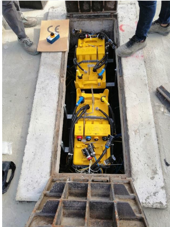
Şekil 3.11 Montajı Yapılan Enerji Kutusu (Powerbox)
