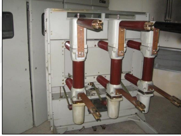
Şekil 2.14 Yağlı kesici
