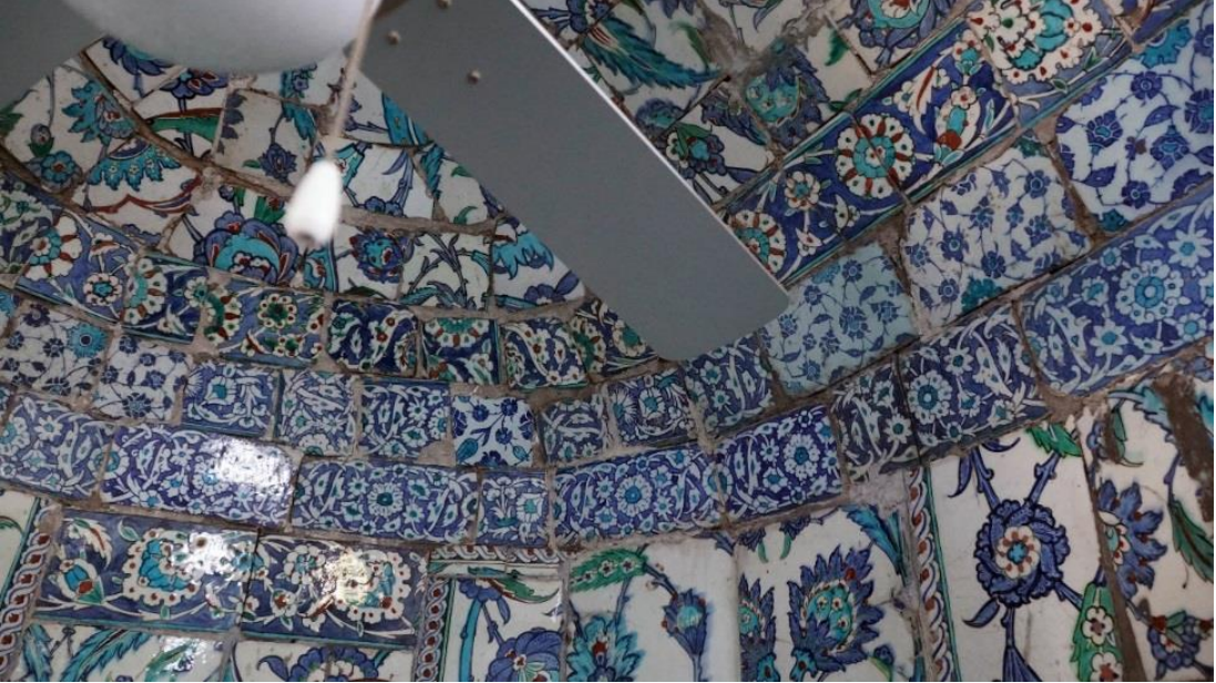
F. 21 Mihrap kavisinin yandan görünüşü
