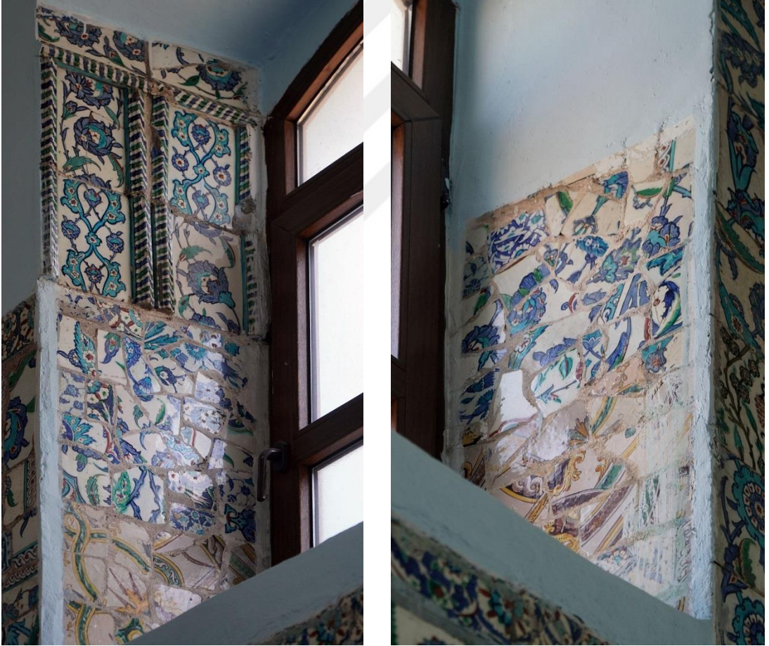
F. 13 Üst sıra, sol pencere iç duvarları
