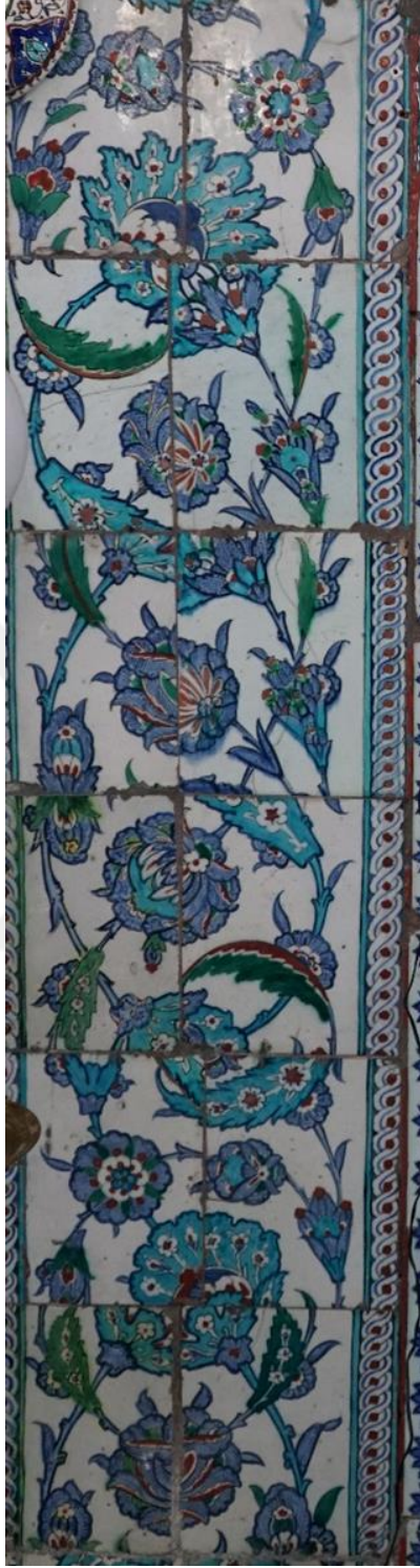
F. 101 Handan Ağa Camii Mihranın sağında kalan duvar
