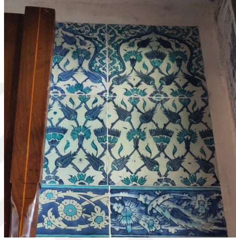
F. 136 Hatice Sultan Türbesi pencere iç duvarları
