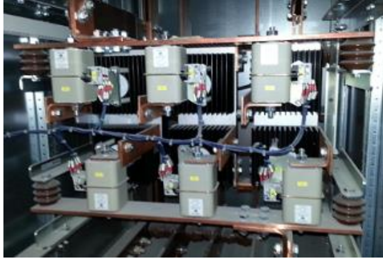
Şekil 2.17 : 1 faz için diyot grubu.
