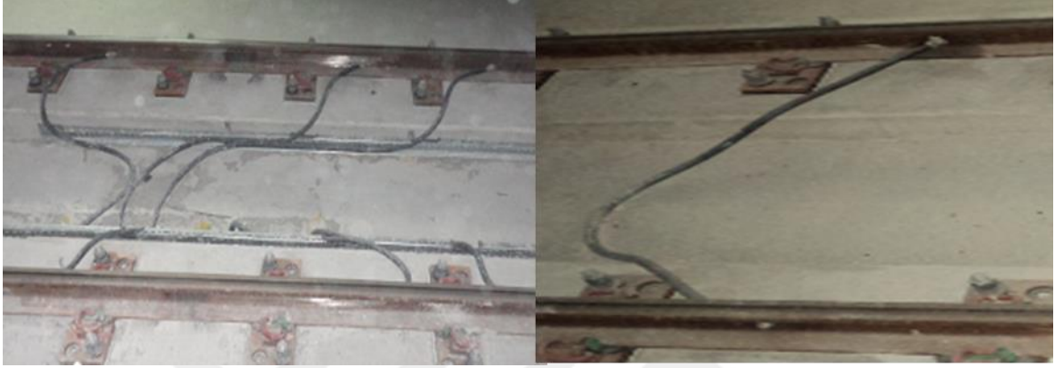
Şekil 2.14 : Ray bağlantı kabloları.
