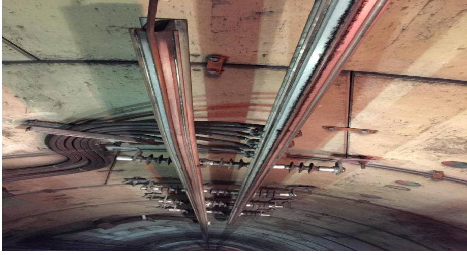
Şekil 2.23 : Rijit katener ve cer gücü iletimi.
