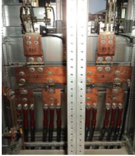
Şekil 2.21 : Negatif geri dönüş panosu ve ayırıcı.
