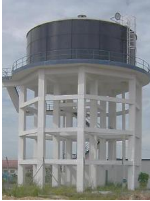
Şekil 1.1: Kolon ve kirişlerle desteklenen su tankı [1].
