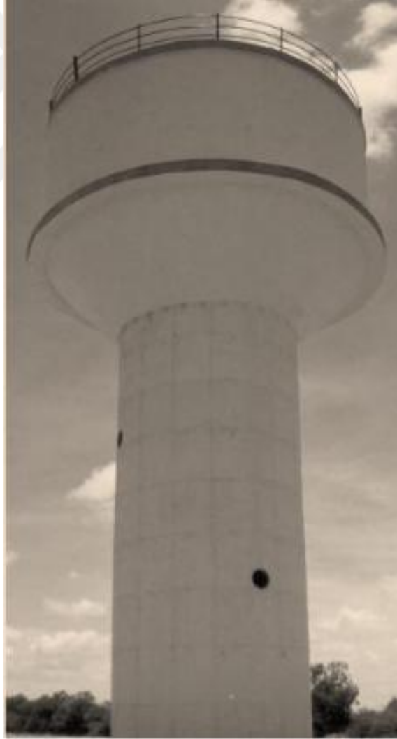
Şekil 1.2: İçi boş dairesel şaft tipi su tankı [1].
