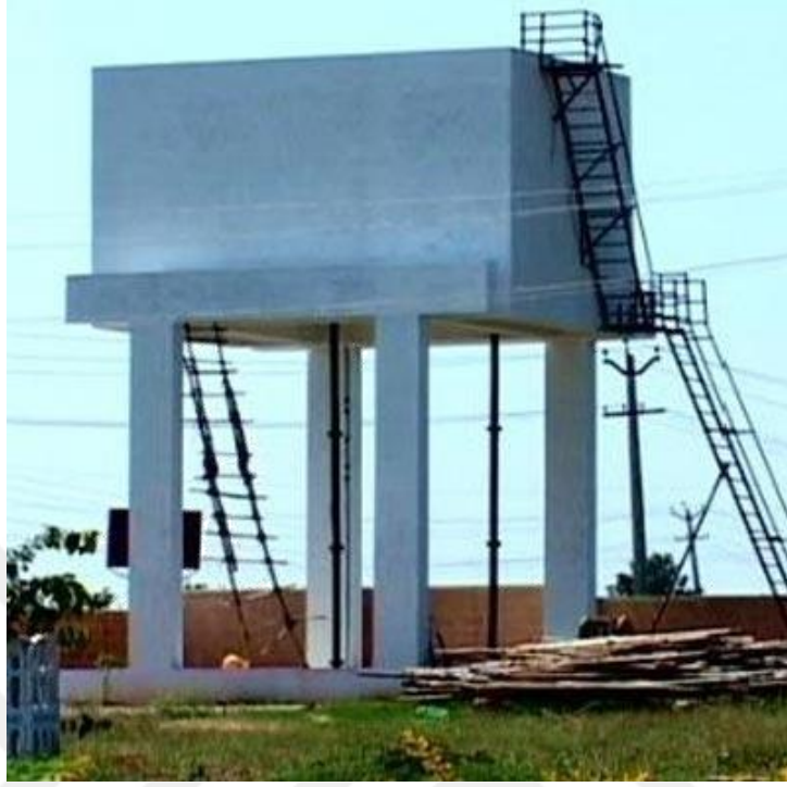
Şekil 1.7: Dikdörtgen su tankı [8].
