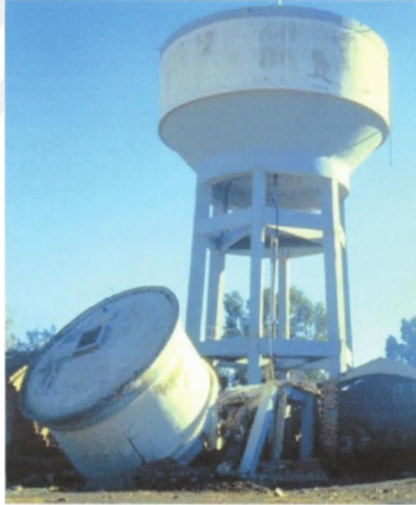
Şekil 2.8: Cezayir El-Asnam depreminden sonra su tankı [2]
