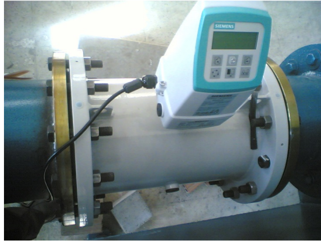
Şekil 3.10 Giriş debisini ölçen elektromanyetik debimetre
