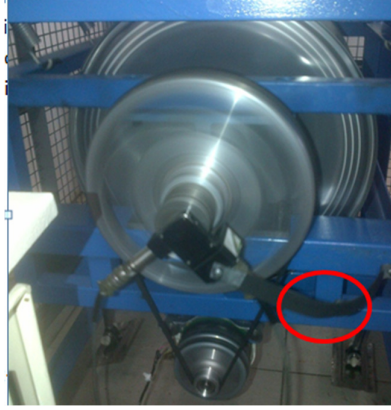
Şekil 3.30 Torkmetre ile oturak arasındaki bağlantı.
