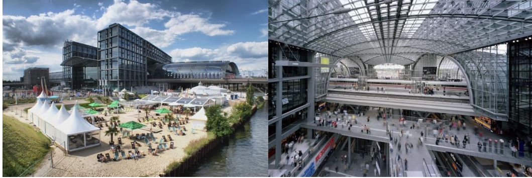
Şekil 4.8 : Berlin Hauptbahnhof (Merkez) İstasyonu, (Url-20,21)
