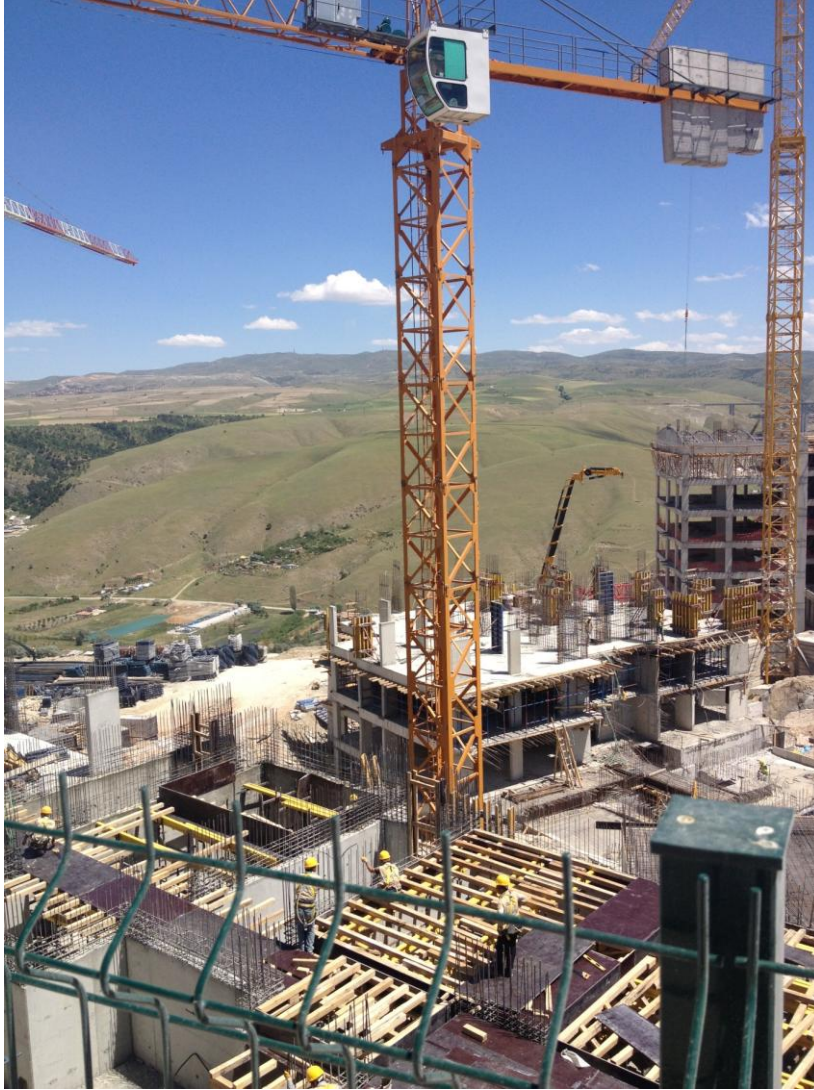
Resim 3.3.53. Sinpaş Altınoran - İnşaat Aşaması
