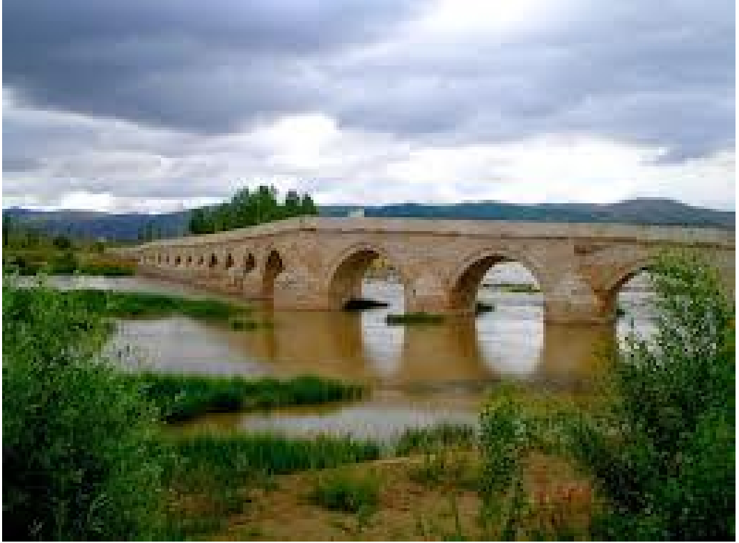
Ek 8: Eğri Köprü
