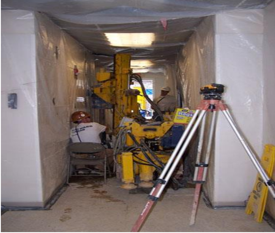
Şekil 2.5. Mevcut bina içinde jet grout (haywardbaker)
