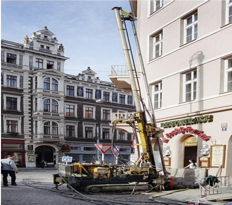
Şekil 2.19. Mevcut yapı zemin iyileştirmesi (zakladani)
