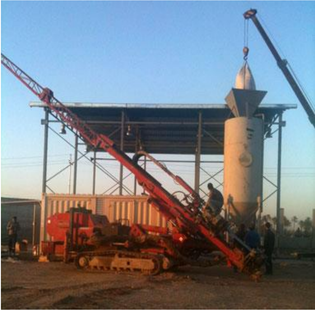
Şekil 2.24. Jet grout sistemi (zemin araştırma)
