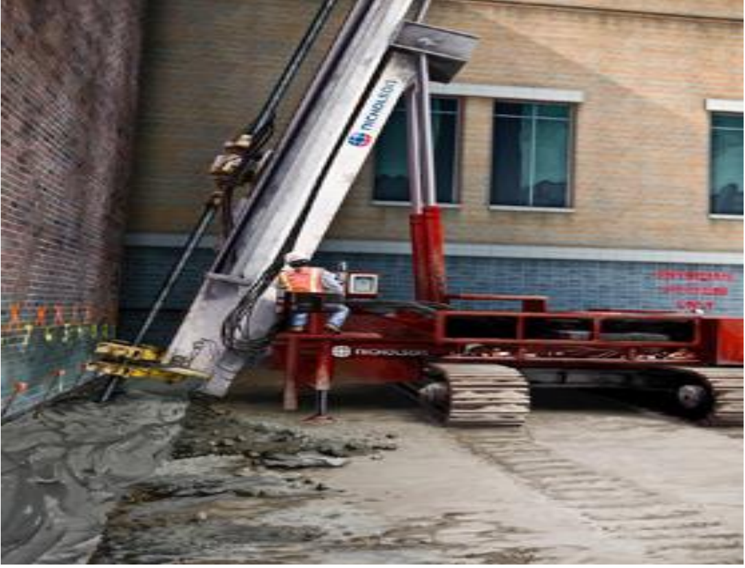
Şekil 2.7. Komşu bina temeli desteklenmesi (nicholson construction)
