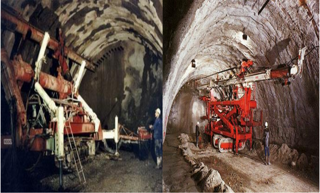
Şekil 2.15. Tünel aynası ve tavanının desteklenmesi (rodio gmhb)
