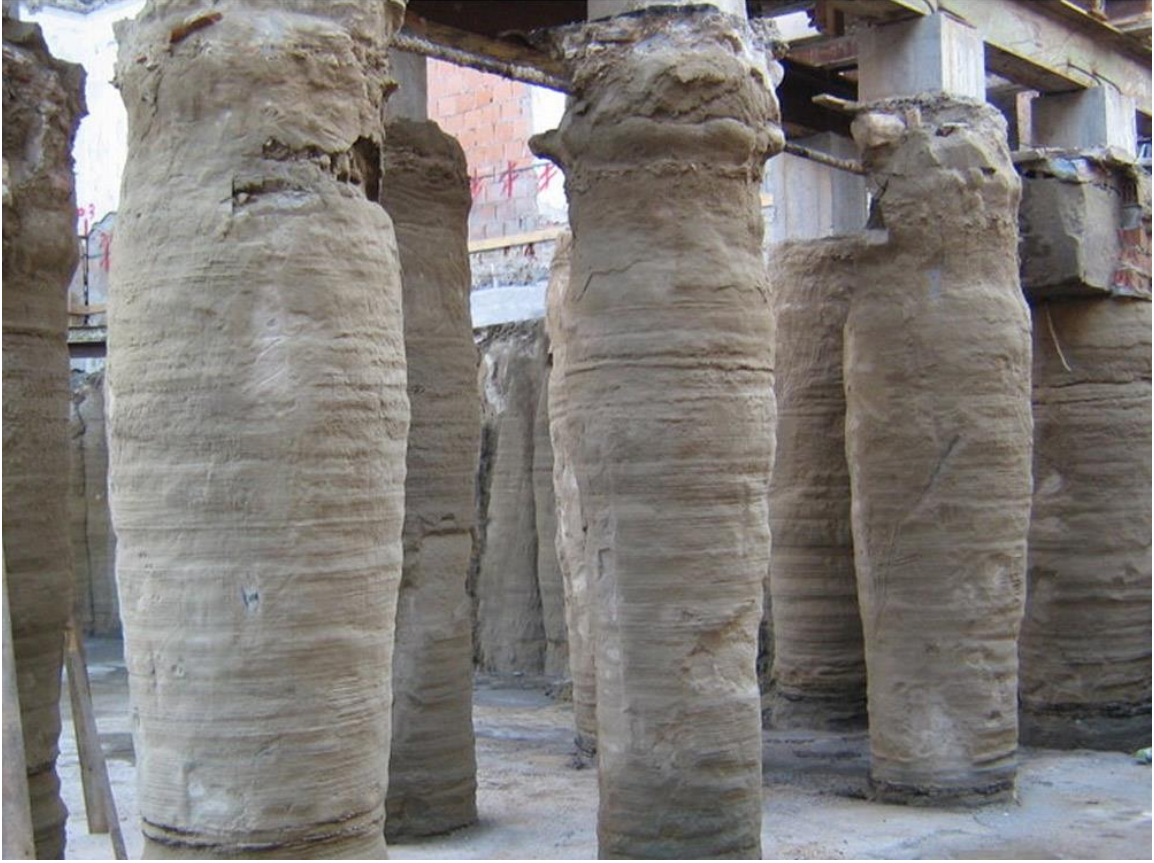
Şekil 2.4. Zemin ortamında üretilmiş jet grout kolon (Geosistema)
