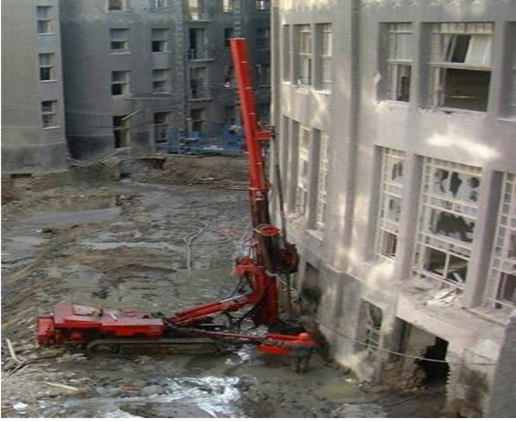
Şekil 2.20. Yeraltı suyu sebebiyle stabilitesi azalmış, oturma görülen zeminin ıslahı (emab zrt)
