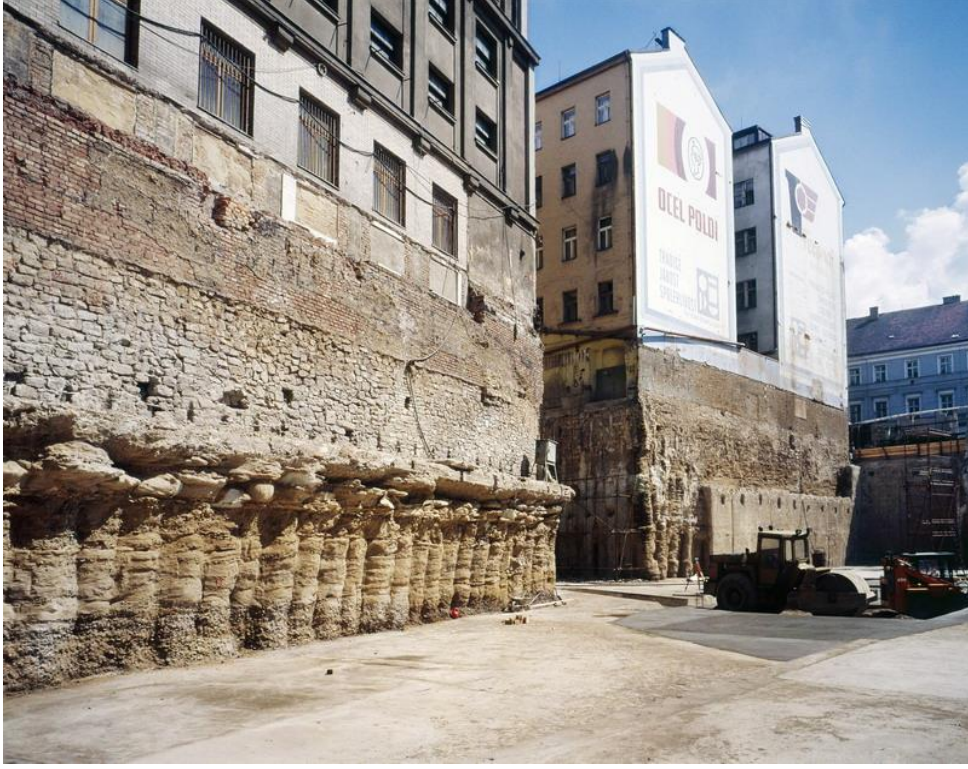
Şekil 2.18. Mevcut yapı zemin iyileştirmesi (Penta Hoteli Prag,zakladani)
