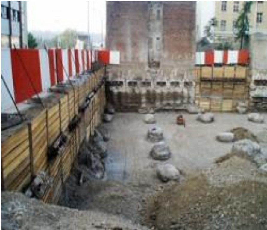
Şekil 2.21. Yeni bina yapılacak bir alanda zemin iyileştirmesi (zakladani)
