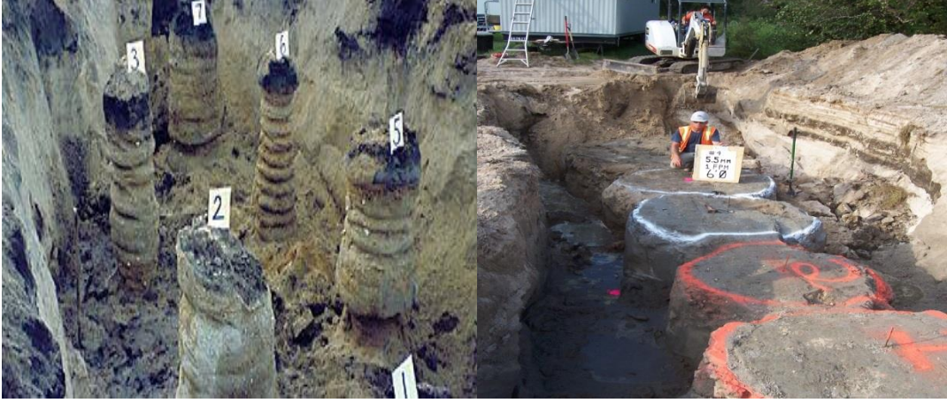
Şekil 2.31. Jet grout kolonlarda kalite kontrolü (earth tech-geosolutions)
