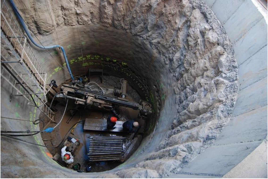
Şekil 2.22. Şaft kazısı için perde yapılması (zakladani)
