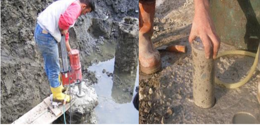
Şekil 2.33. Jet grout kolonlardan karot alınması (geodata-geoteknik)
