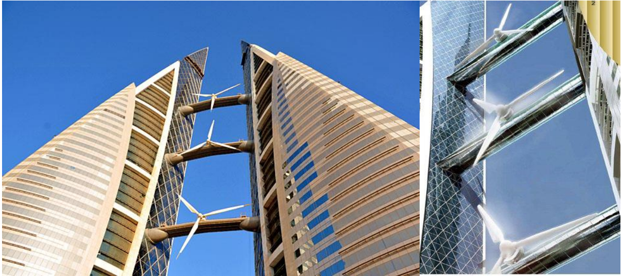
Şekil 52 ve 53: Bahreyn Dünya Ticaret Merkezi’nin rüzgar pervaneleri
