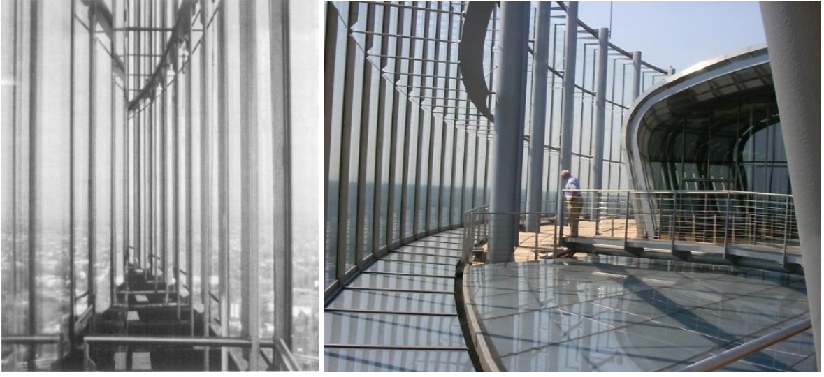
Şekil 58 ve 59: Deutsche Post, Bonn, Almanya. Yapının çift kabuk cephesi enerji tüketimini önemli ölçüde azaltmaktadır.
