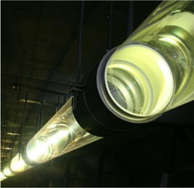
Şekil 43: Işığı uzun mesafeler boyunca dağıtan sistem
