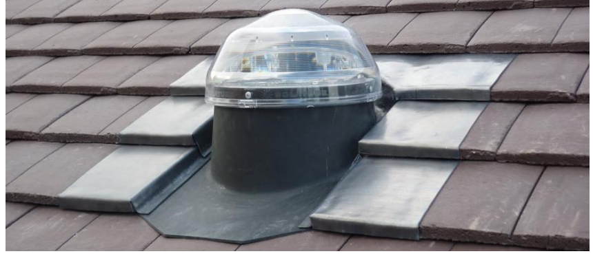
Şekil 41: Güneş ışığını toplamak için çatıya yerleştirilen kısım
