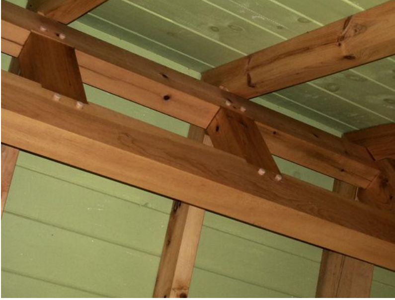
Şekil 7: Geleneksel bir Çin konutunda ahşap çatı konstrüksiyonu
