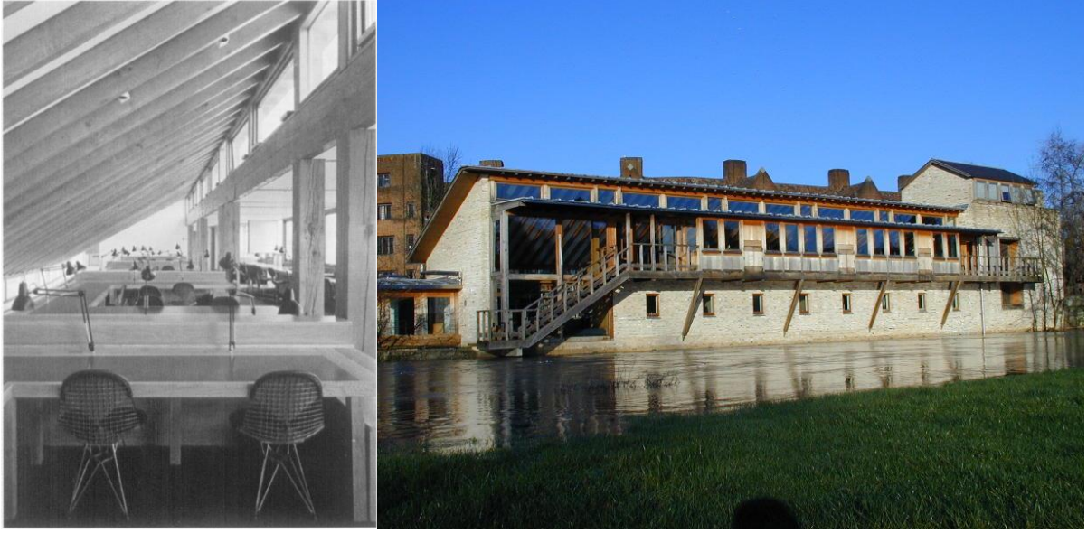
Şekil 33 ve 34 : Darwin Koleji Çalışma Merkezi, Cambridge. Yapının taşıyıcı elemanları, cephe kaplamaları, doğramalar, döşeme kaplamaları, kitaplık ve diğer mobilyalar %100 geri dönüştürülebilen ahşap kullanılarak üretilmiştir.
