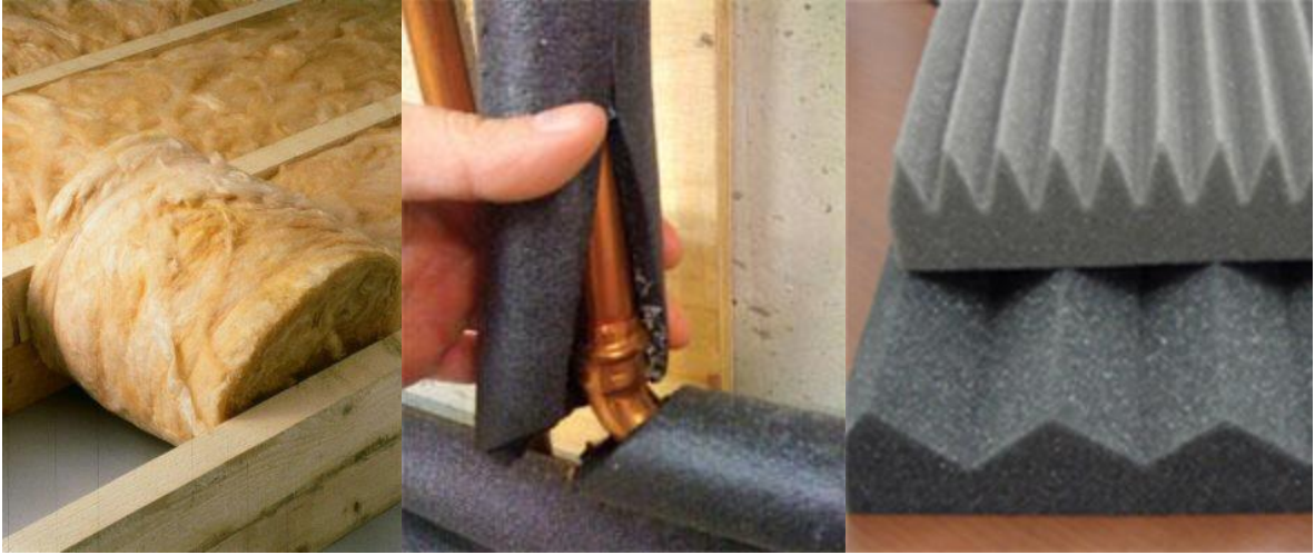
Şekil 57: Yapılarda yalıtım yöntemleri
