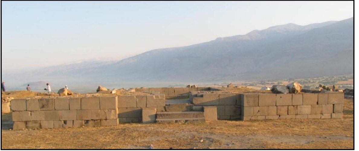
Res. 23 Altintepe Urartu tapınağının ön cephe görünüşü (Altintepe kazı arşivi).
