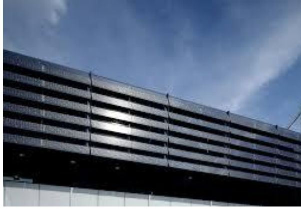
Şekil 3.41 : Fotovoltaik panellerin yatay gölgeleme bileşeni kullanımı [72].
