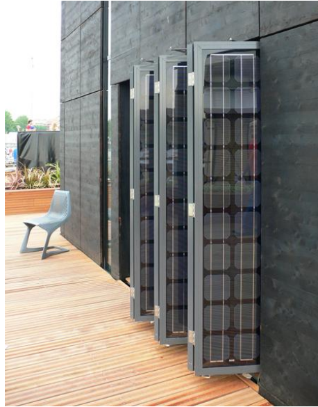
Şekil 3.42 : Fotovoltaik panellerin düşey gölgeleme bileşeni kullanımı [73].
