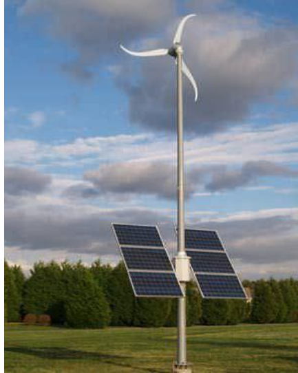
Şekil 3.19 : Hibrid sistem uygulaması [51].
