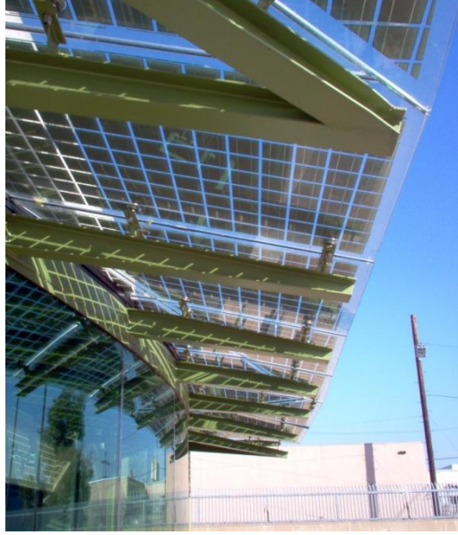
Şekil 3.39 : Fotovoltaik panellerin sabit gölgeleme bileşeni olarak kullanımı [70].
