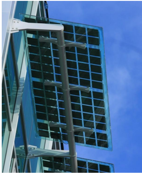
Şekil 3.40 : Fotovoltaik panellerin hareketli gölgeleme bileşeni olarak kullanımı[71].
