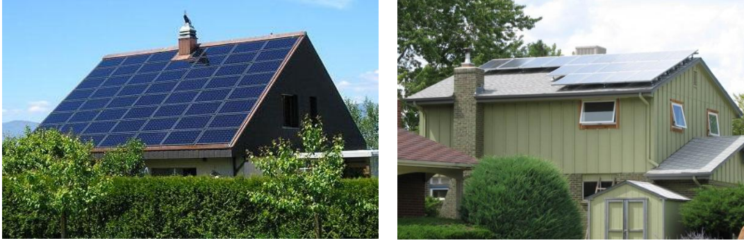
Şekil 3.27 : Panellerin bacalar tarafından gölgelenmesi [16].
