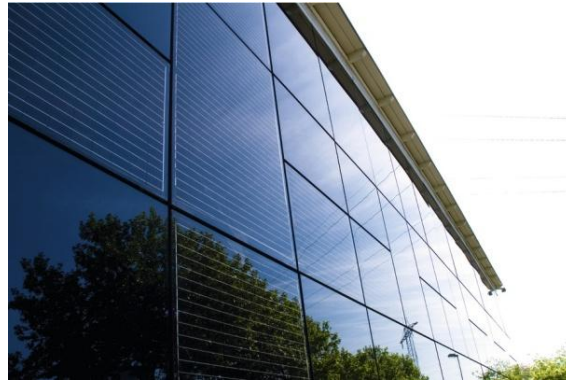
Şekil 3.36 : Tüm cephe yüzeyine uygulama [65].
