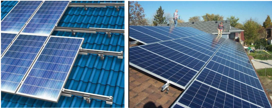
Şekil 3.31 : Panellerin eğimli çatı yüzeyinde ızgaralar üzerine yerleştirilmesi [62]
