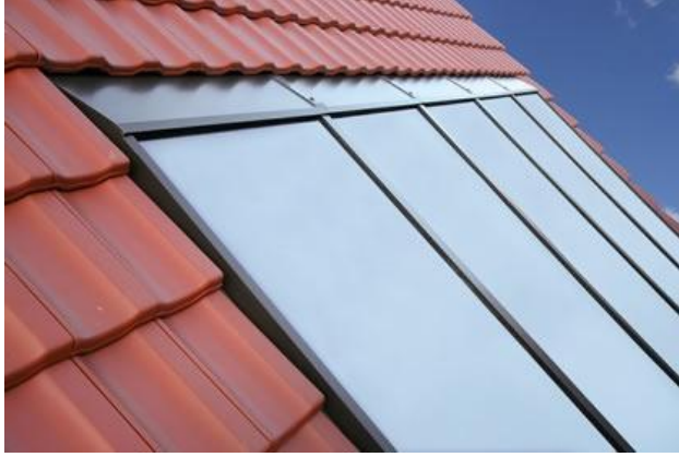
Şekil 3.32 : Fotovoltaik panellerin çatı kiremtlerinin arasına yerleştirilmesi [63].
