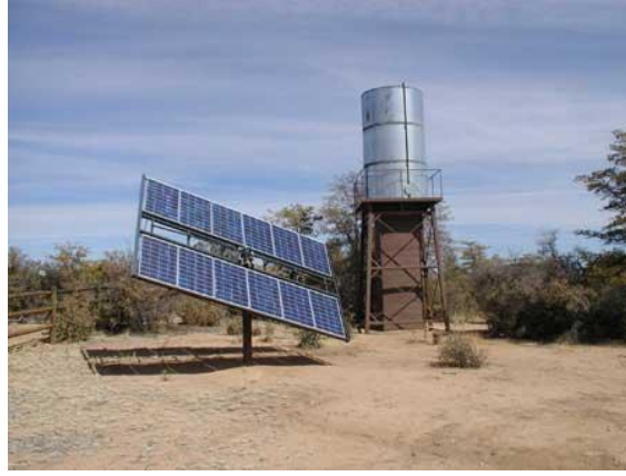
Şekil 3.16 : Fotovoltaik panellerin su pompası için kullanımı [49].
