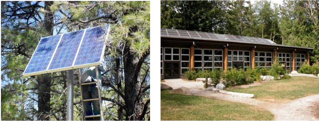
Şekil 3.24 : Fotovoltaik panellerin diğer ağaçlar tarafından gölgelemesi [16].
