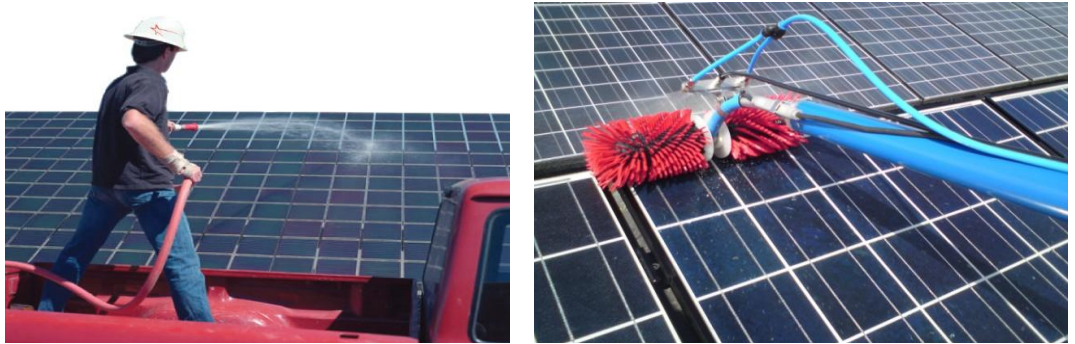
Şekil 3.29 : Panel yüzeyinin su ve fırça yardımıyla temizlenmesi [16].
