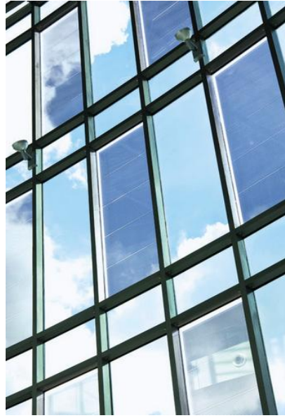
Şekil 3.38 : Bina cephesine yarı geçirgen panellerin uygulanması [67].
