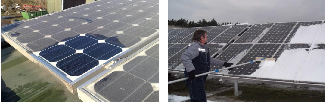
Şekil 3.28 : Panellerin üzerinin toz ya da kar ile kapanması [16].
