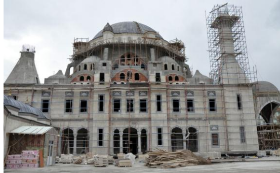
Şekil 1.5. Kırıkkale Nur Cami inşaatından bir görüntü
