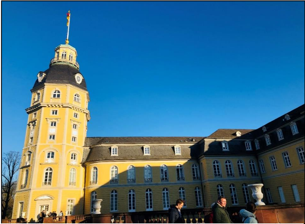
Fotoğraf 16: Karlsruhe Sarayı'nın dış cepheden görünüşü
