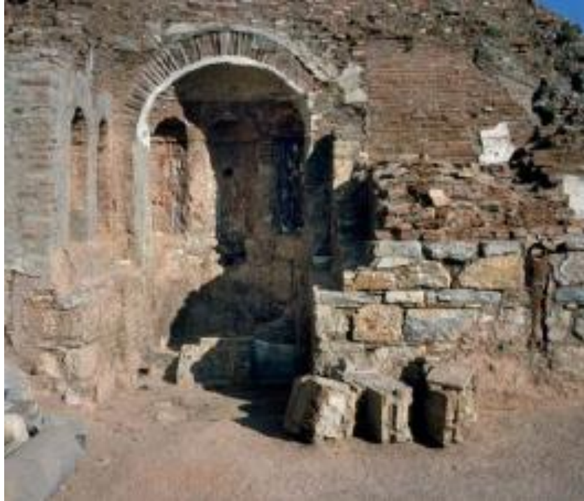
Fig. 61: Ephesos 1 nolu Yamaç Ev, Domus içerisindeki çeşme yapısı.
